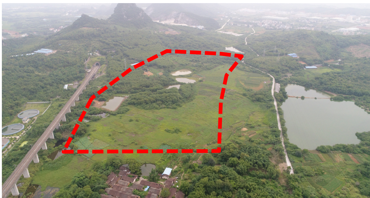
图 5-15 建议选址用地三现状照片
