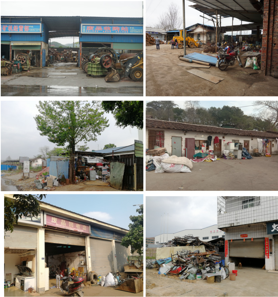
图 3-14 回收站点建筑现状
