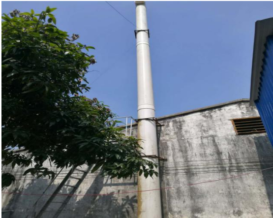
喷涂废气排气筒
