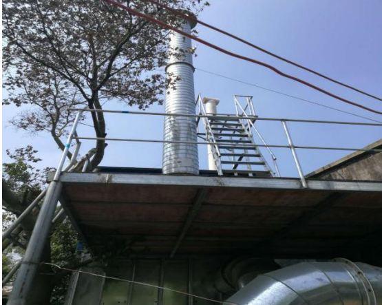
粉尘废气排气筒
