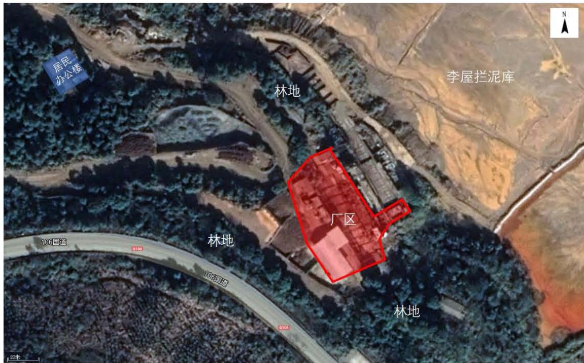
图 4 厂区周边情况图
