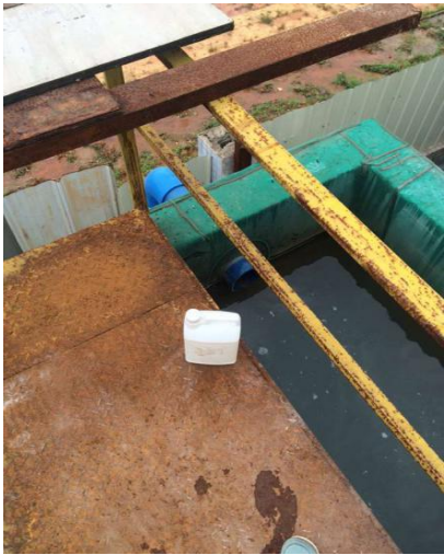
生产车间含镍废水排放口
