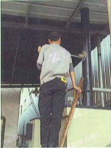
2#备用锅炉废气排放口
