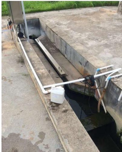
园区污水处理厂排放口
