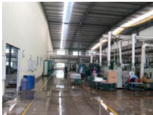
厂房预留消防通道
