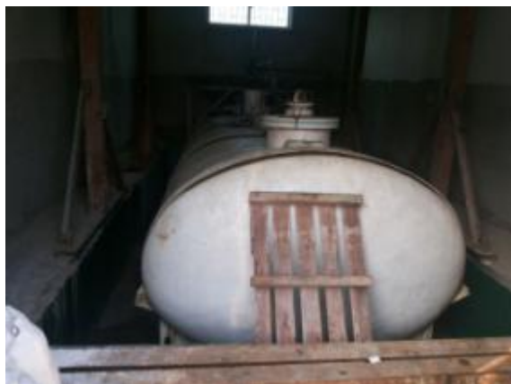
酸储罐区围堰
