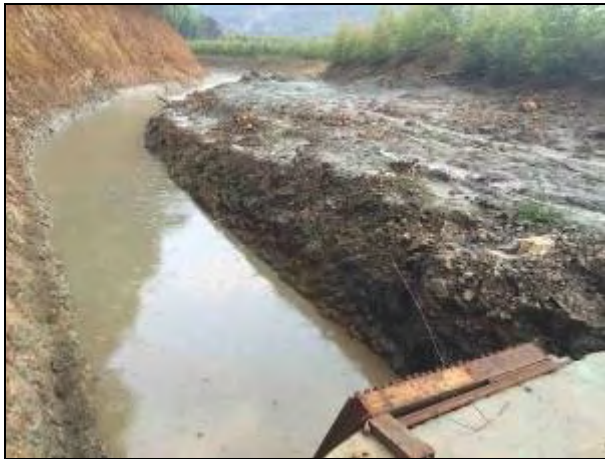
退役尾矿库截排水沟
