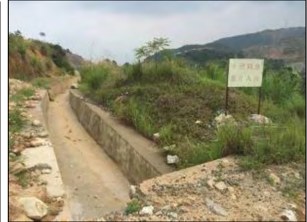
项目矿区已建截洪沟
