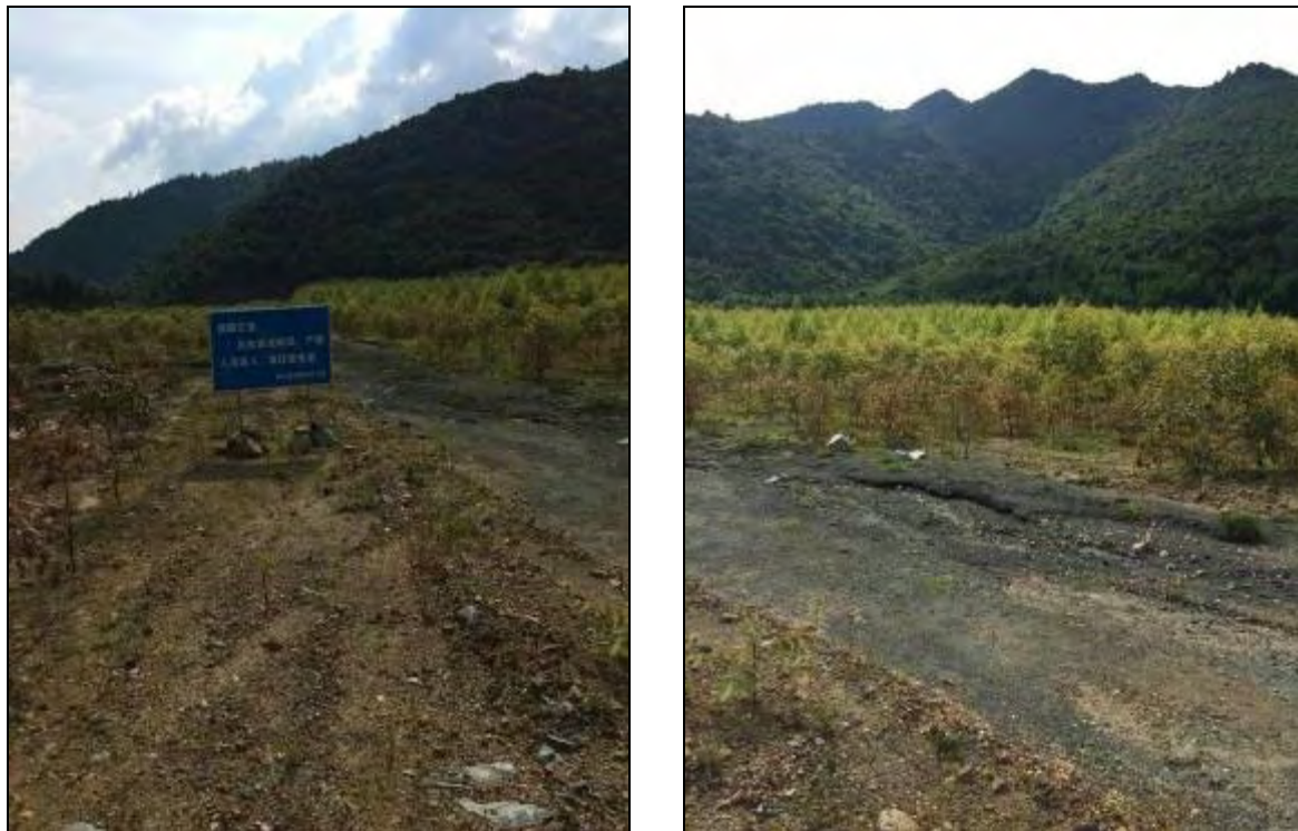
照片 2.4-4 项目已通过闭库验收的尾矿库照片
