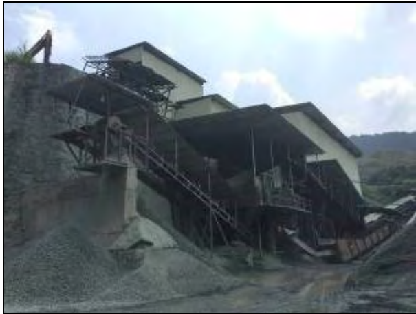
项目矿区现有一选厂
