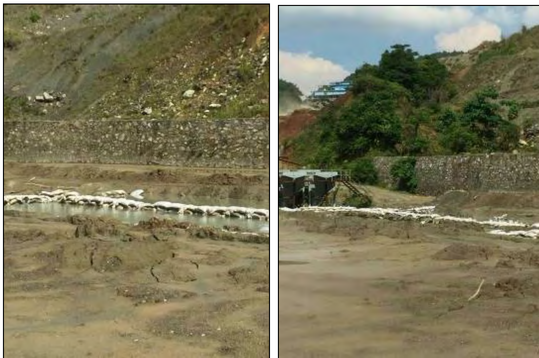
照片 2.4-3 项目前期开采遗留区(即二号排土场)整治工作照片
