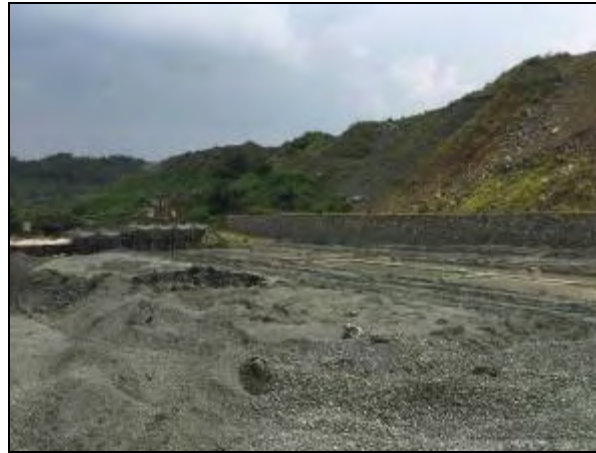
项目一选厂已建尾砂脱水设施
