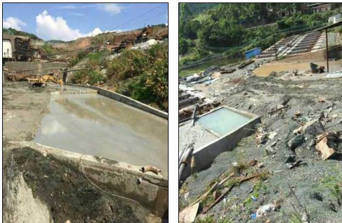
照片 2.4-5 项目已建沉淀池照片
