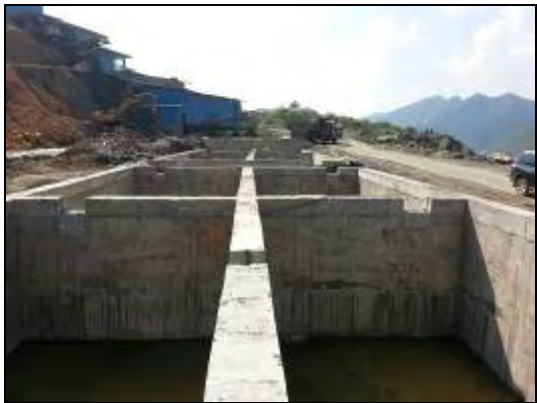
二选厂沉淀池
