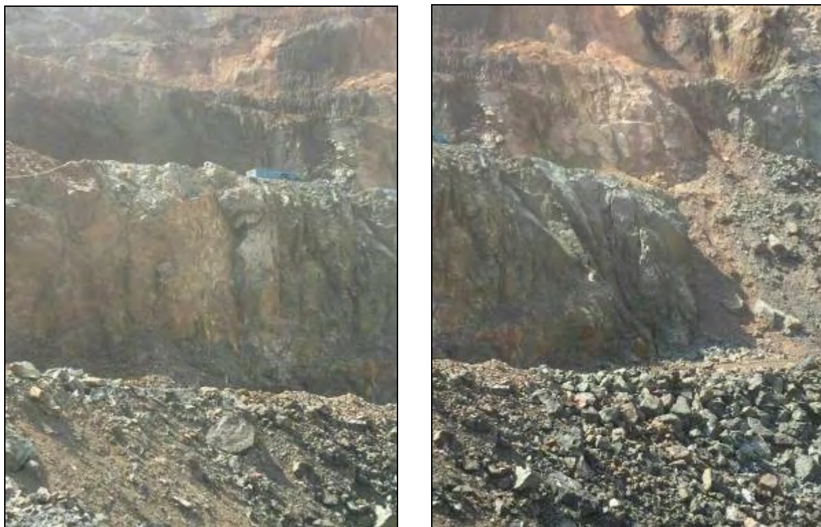
照片 2.4-1 项目露天采场高陡边坡整治工作照片
