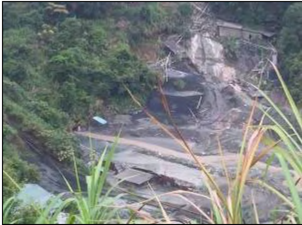
项目已建露天采坑排水巷道排放口
