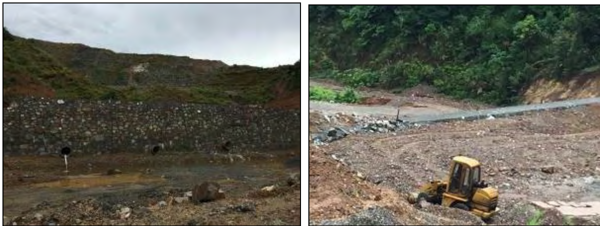
照片 2.4-2 正在施工阶段的排土场整治工程
