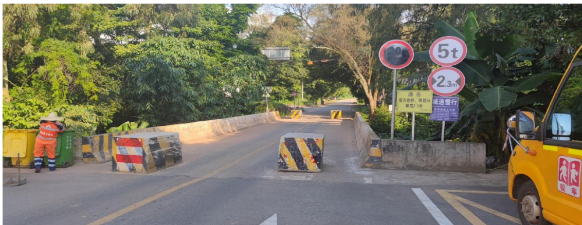
图 2-14 桥梁一现状（位于邓坊卫生院南侧 200m）
