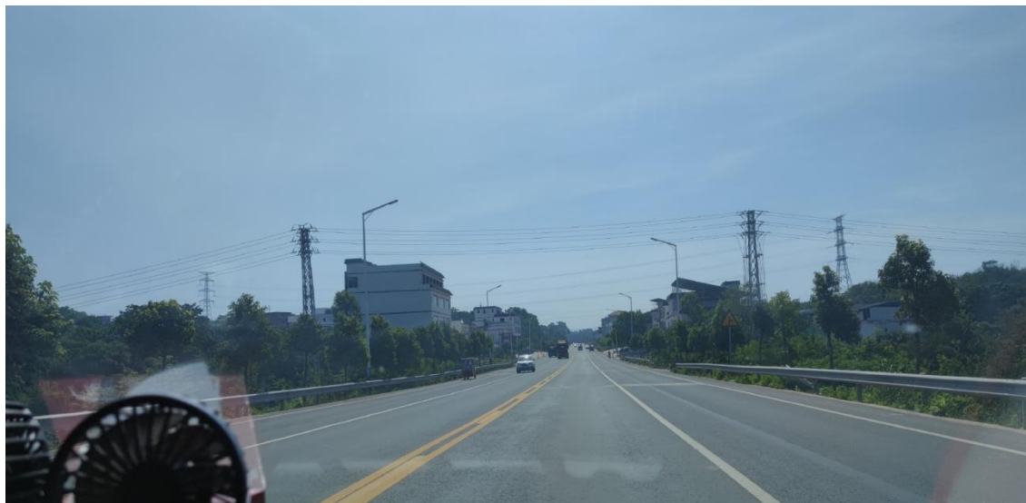
图 2-9 省道 S342 现状（双向四车道，宽度 15m）
