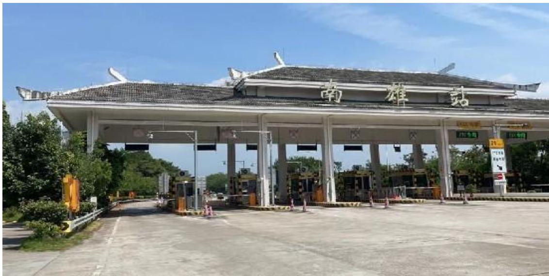
图 2-5 南雄收费站现状（超宽段满足通行）
