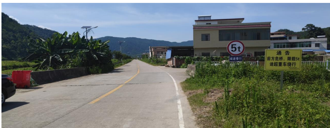
图 2-15 桥梁二现状（位于邓坊镇老屋村）
