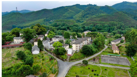
核工业741矿工业建筑群
