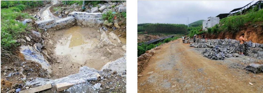
已建简易沉沙设施及在建边坡防护设施
