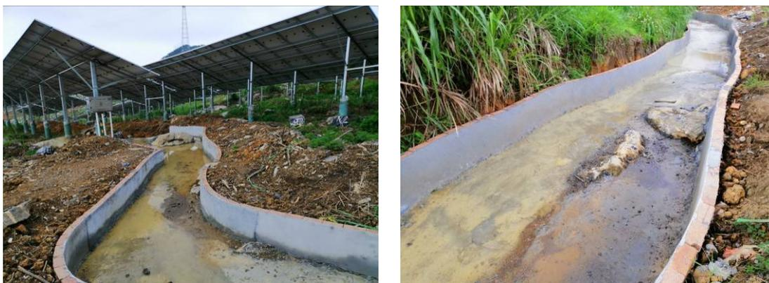
图5.3-1 加固衬砌的排水沟（2020年5月）
