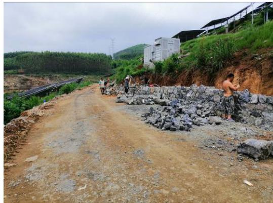
项目架空线路的塔基以及正在实施的挡土墙（2020年5月）
