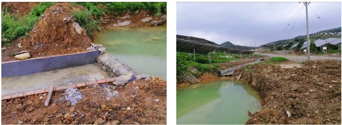
图5.3-3 加固衬砌的排水沟以及由原小水坑改造的简易沉沙池（2020年5月）
