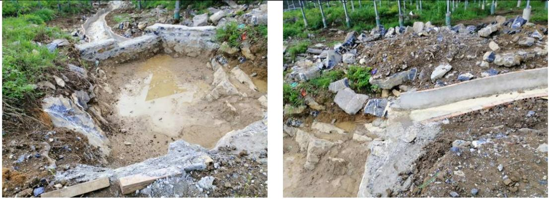
图5.3-2 加固衬砌的排水沟以及由原小水坑改造的简易沉沙池（2020年5月）
