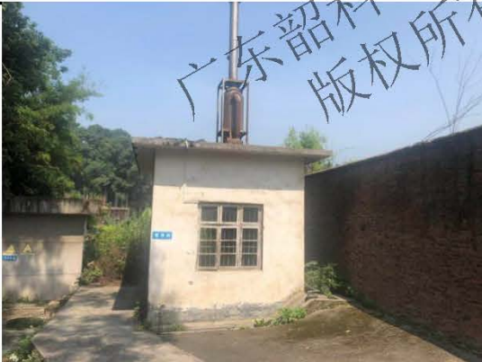
医疗废物暂存间
