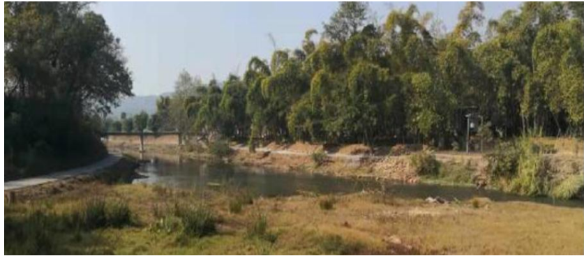
取水工程水陂附近现场图
