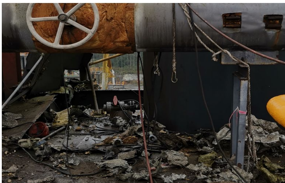
图 12 爆炸后的氯化氢分离塔（十层）
