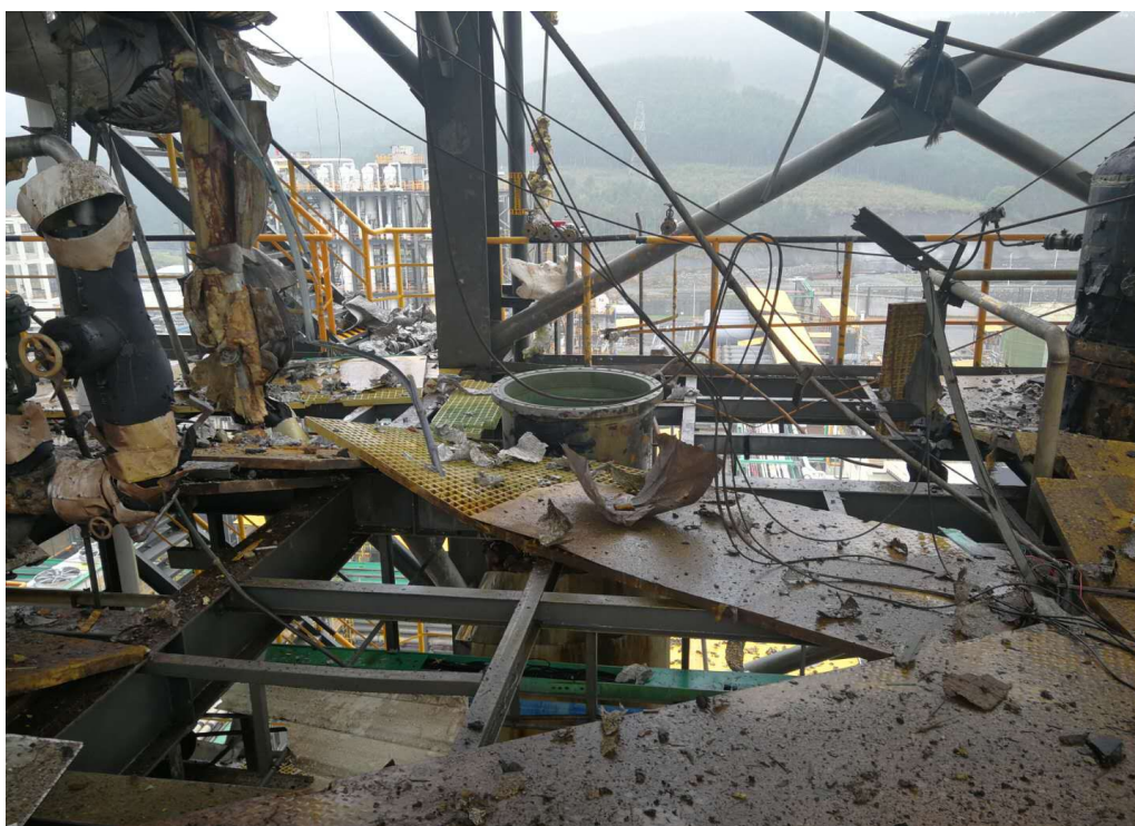
图 4 封头炸飞后的氯化氢分离塔顶部（第九层）
