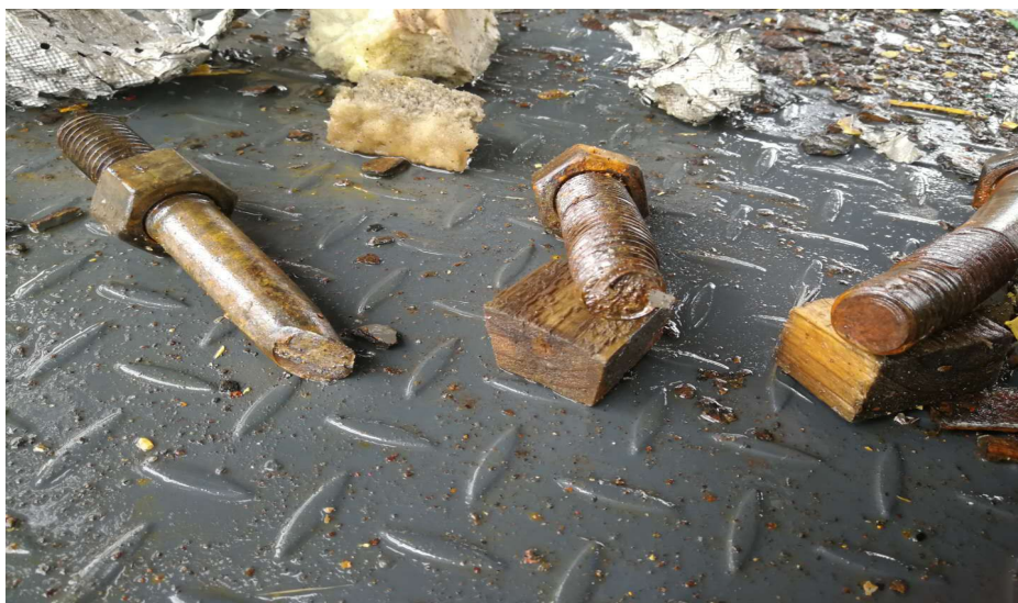
图 6 螺栓损坏类型有：拉伸断裂、拉断、螺帽脱落、螺杆弯曲拉断
