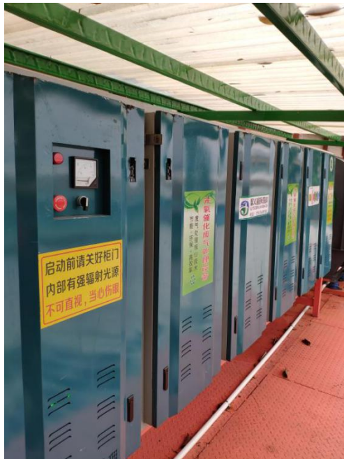
吸塑废气处理设备 2
