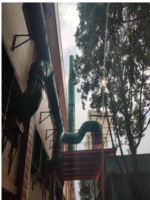
吸塑废气处理设备 1
