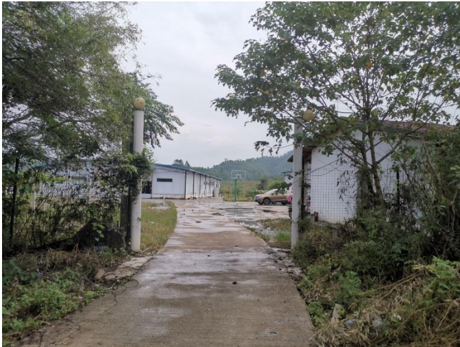
项目西南面（工业厂房）
