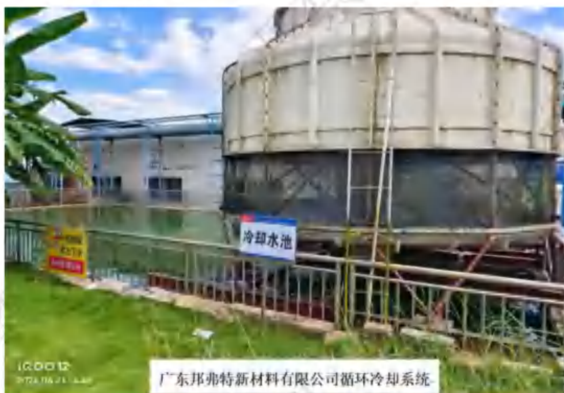
图 6.1-1 基地企业循环冷却系统
