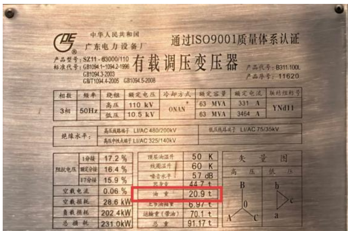
图 2.6-1 同类型 63MVA 主变压器铭牌
