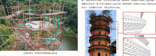
仙人塔塔身现状（2021年）
