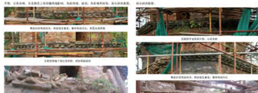
仙人塔塔身现状（2021年）
