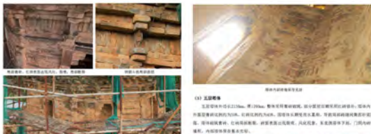
仙人塔塔身现状（2021年）
