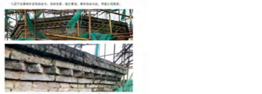
仙人塔塔身现状（2021年）
