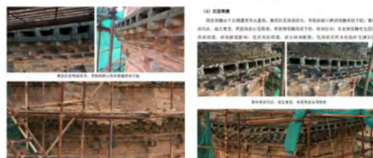
仙人塔塔身现状（2021年）
