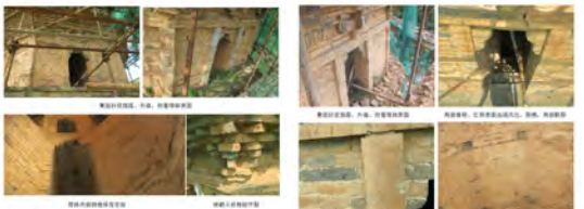
仙人塔塔身现状（2021年）
