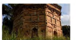
仙人塔塔身现状（2021年）
