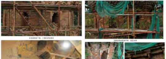
仙人塔塔身现状（2021年）
