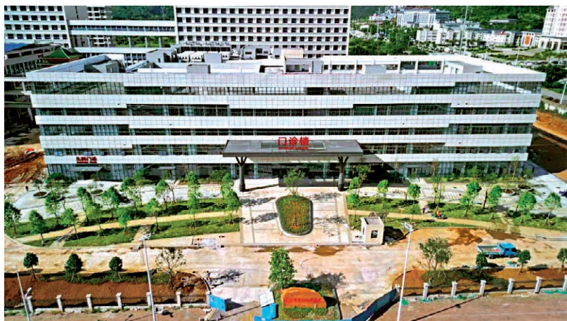
2024年，韶关市第一人民医院建设现场
