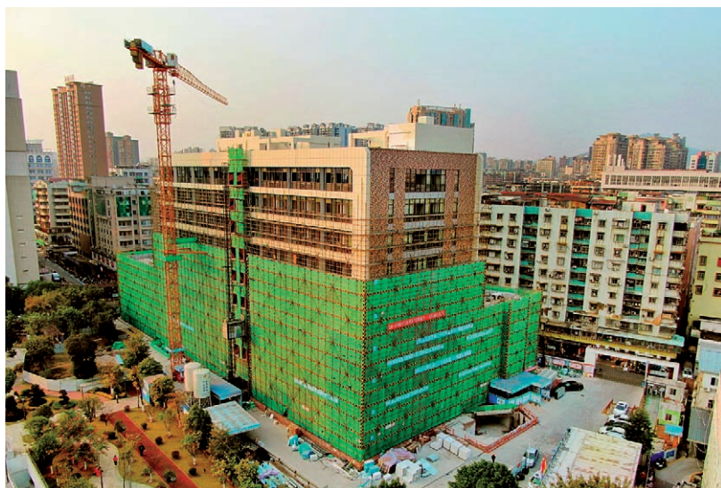
2024年，建设中的粤北人民医院医疗中心辅助功能综合楼
