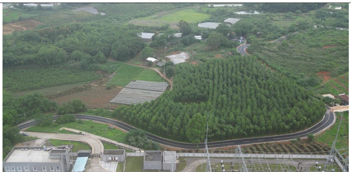
坦界变电站西南侧
