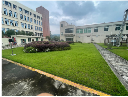
预留#2 主变场地
