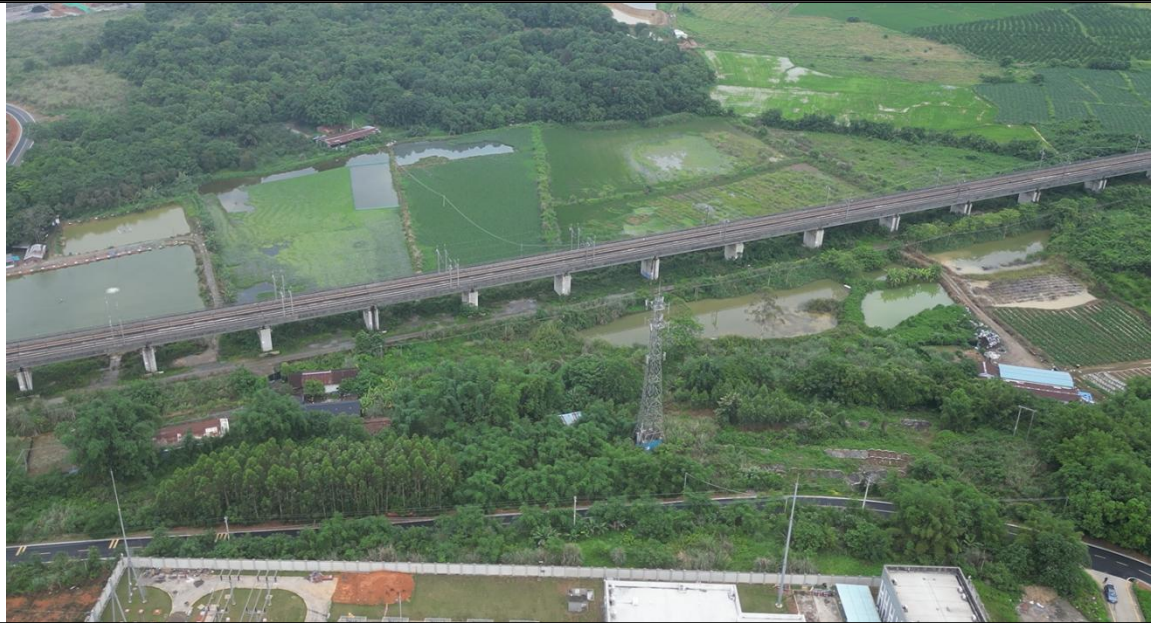
坦界变电站东南侧
