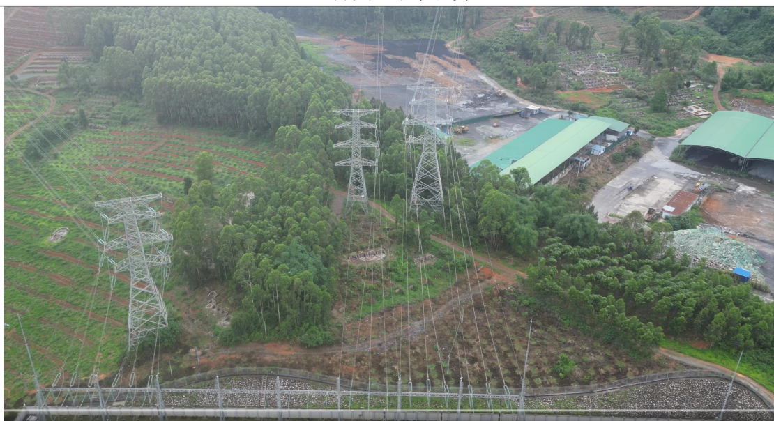
坦界变电站西北侧
