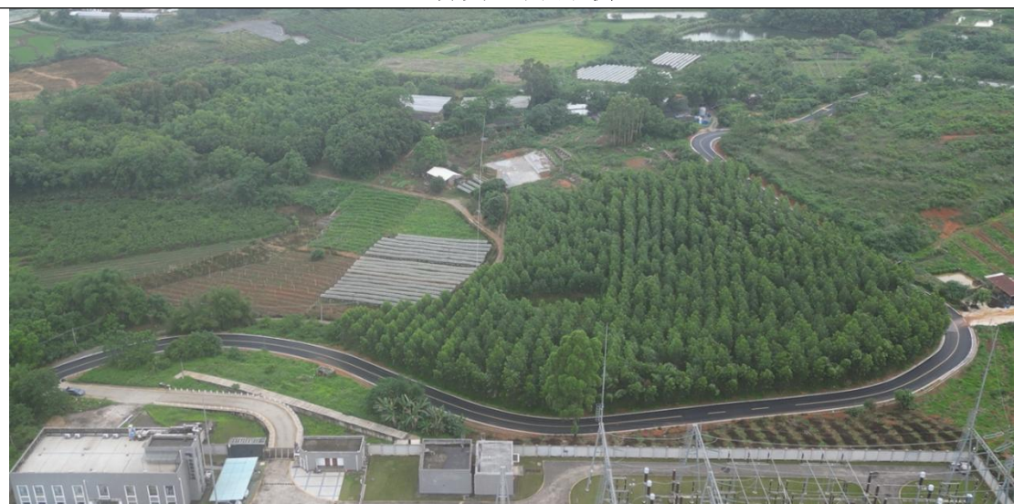
坦界变电站西南侧
