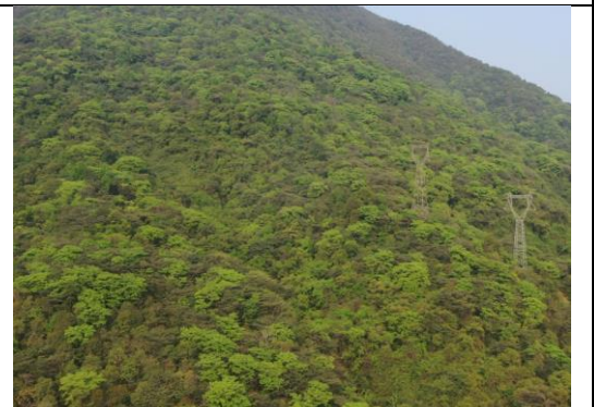
220kV 韶关 B 厂至坑口站线路工程临近生 态保护红线区域
