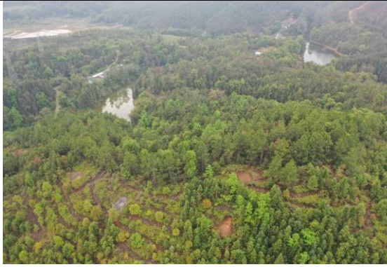
坑口站站址东侧
