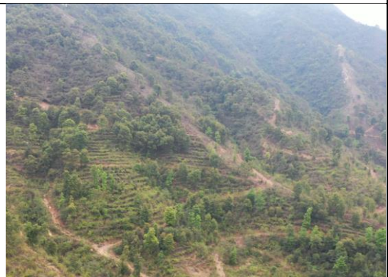
220kV 翁云乙线（云峰侧）改接入坑口站 线路工程临近生态保护红线区域
