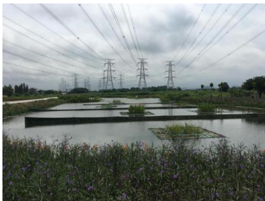
图 1-1-4 沉淀池实景图
