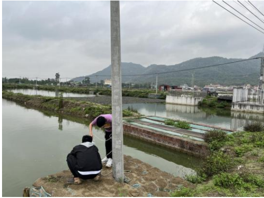
图 1-1-12 沉淀池实景图
