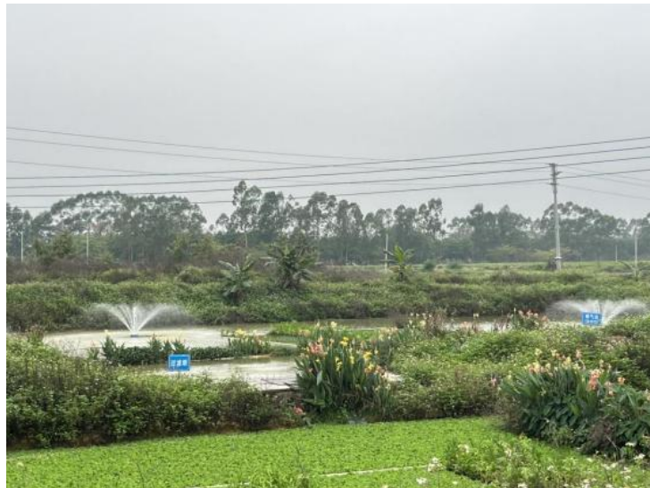
图 1-1-16 生物净化池实景图
