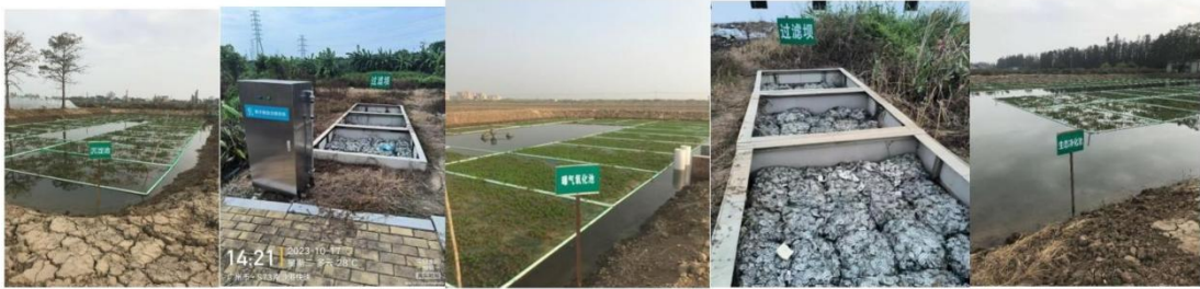
图 1-1-19 沉淀池、过滤坝曝气氧化池及生态净化池实景图
