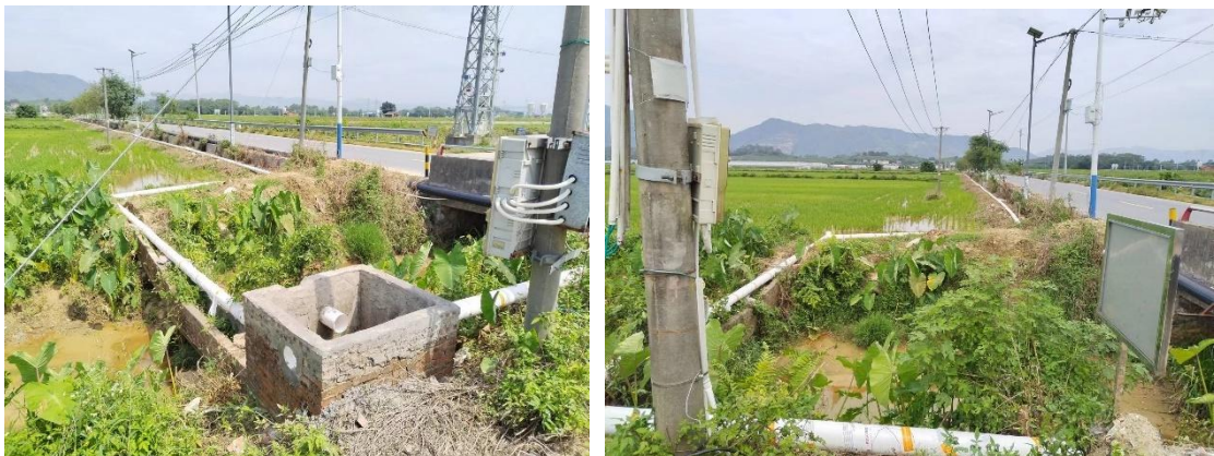
图 1-4-2 渔稻共作尾水处理系统实物图
