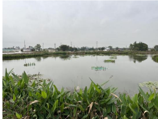
图 1-1-13 曝气池实景图
