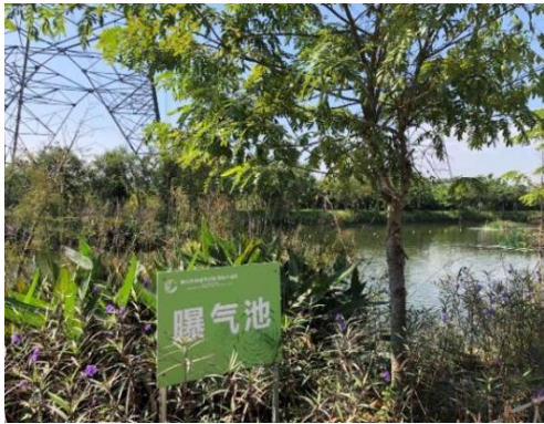
图 1-1-6 曝气池实景图
