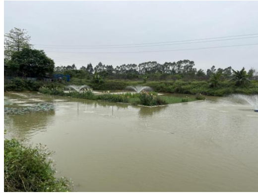
图 1-1-15 曝气池实景图
