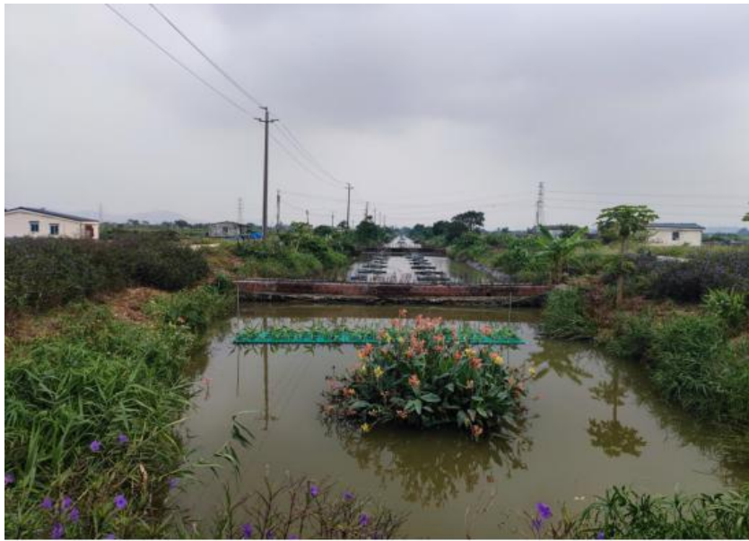
图 1-2-2 立体吸附桩养殖尾水治理技术模式工程实物图
