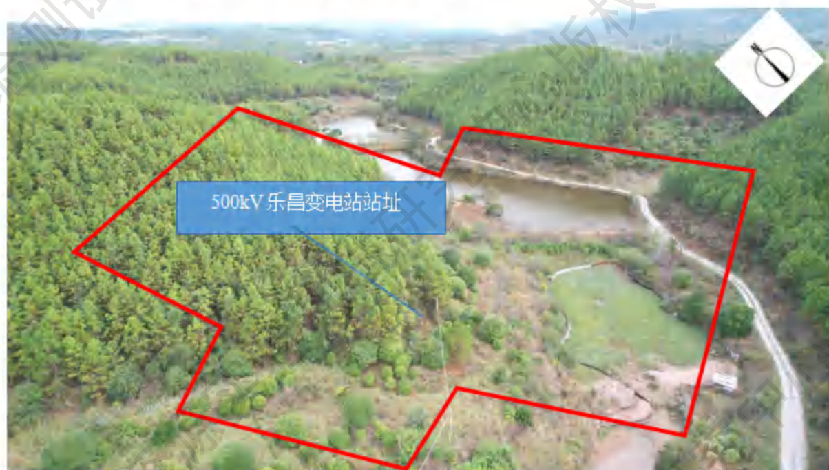
图 3.1-2 500kV 乐昌变电站站址现状
