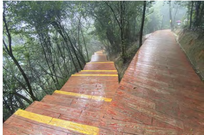
更换易湿滑步道铺装
