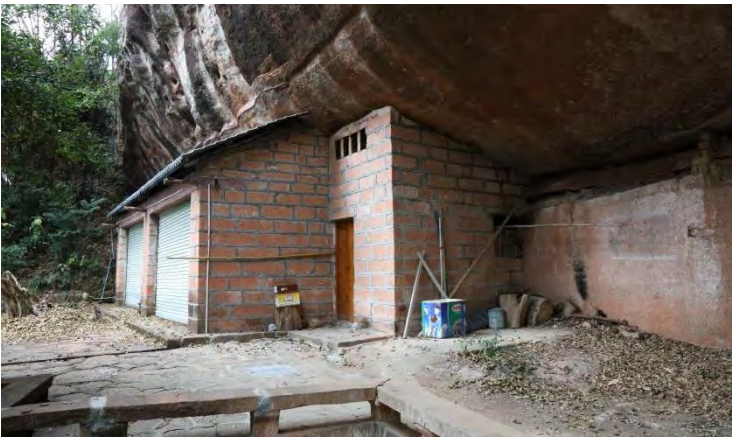
石乳泉西北侧闲置建筑
