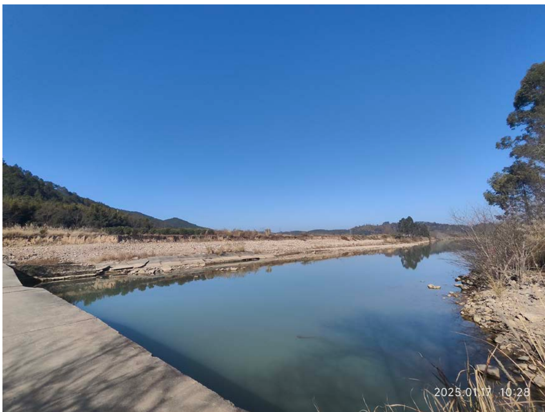
主体工程区起点现状图
