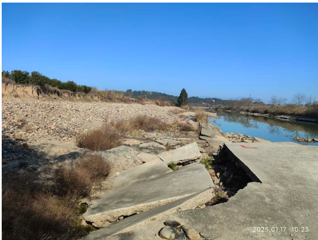
主体工程区起点现状图
