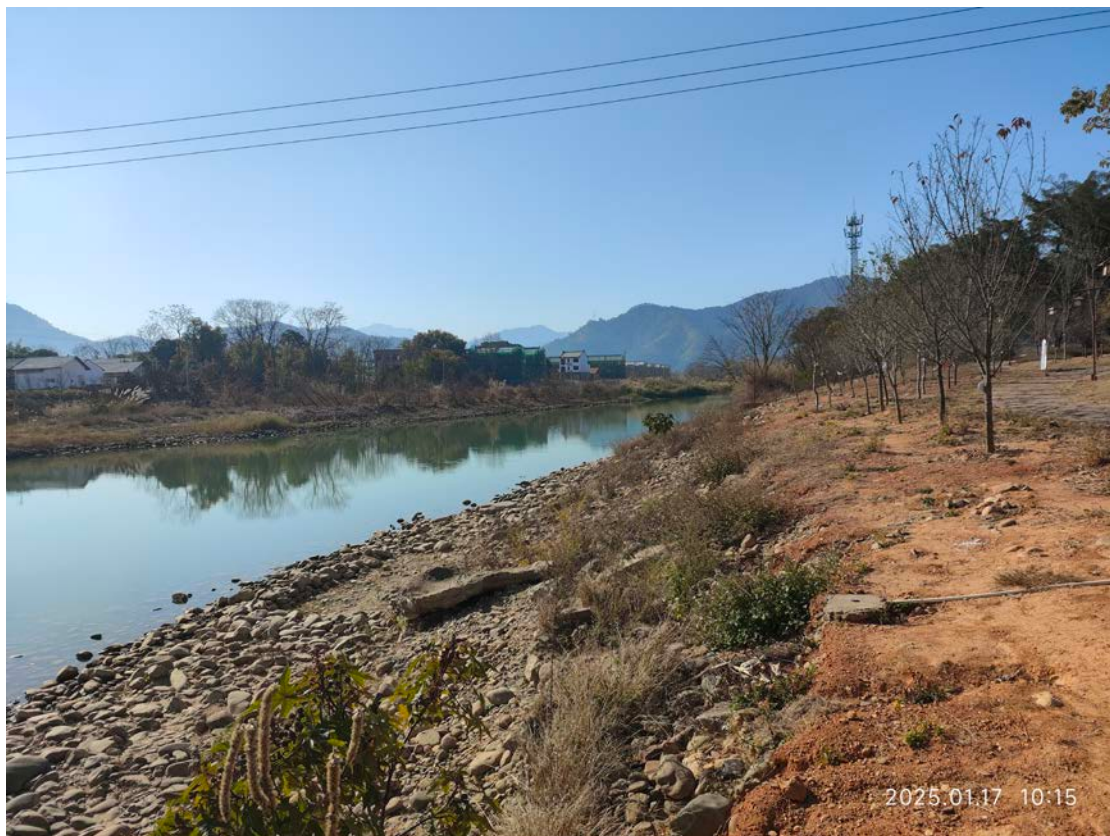
主体工程区终点现状图
