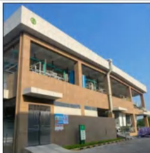
废水处理车间
