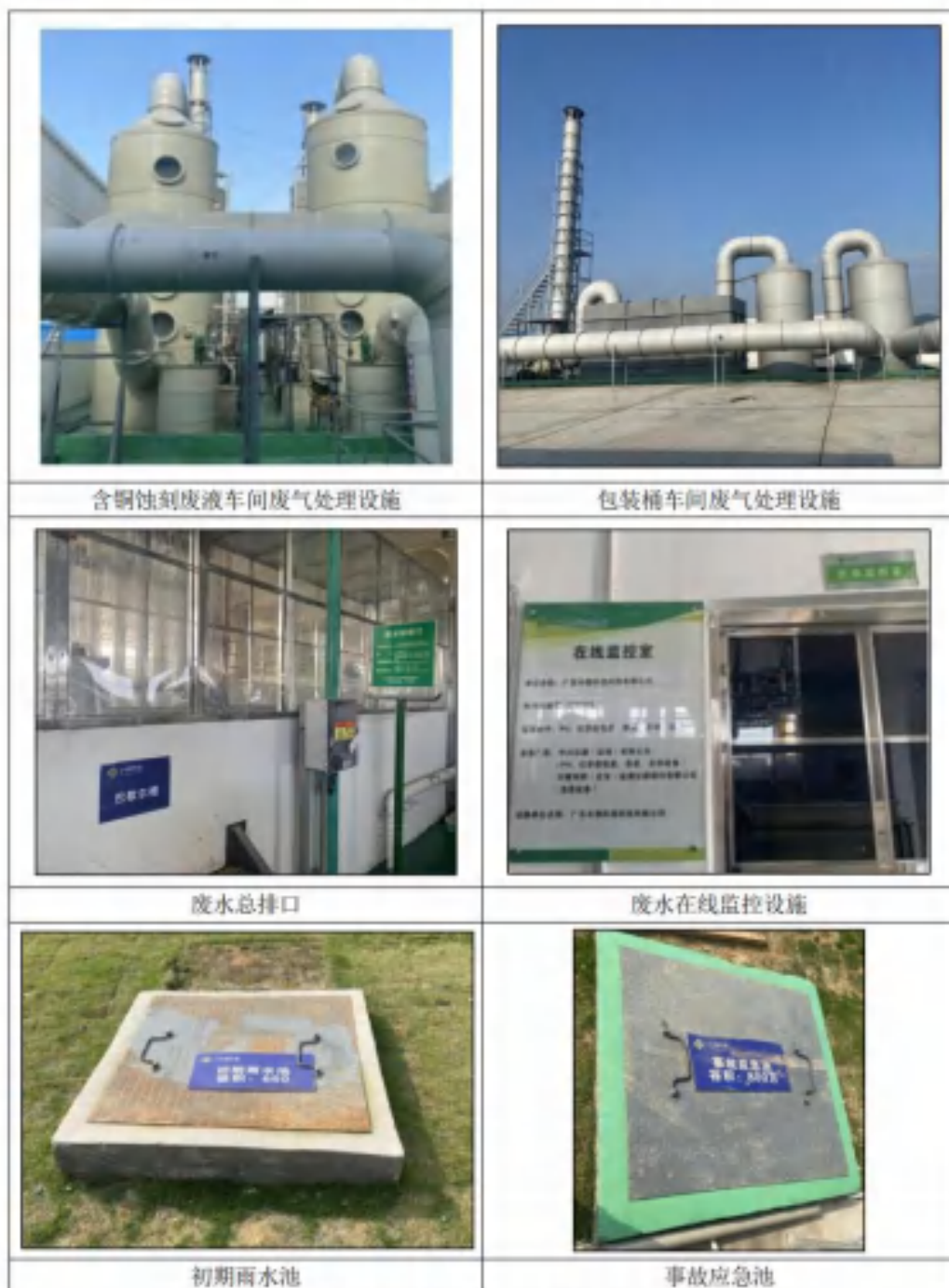
图 3.1.1-2 现有已建工程建设情况图
