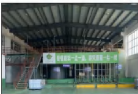
含铜蚀刻废液车间罐区
