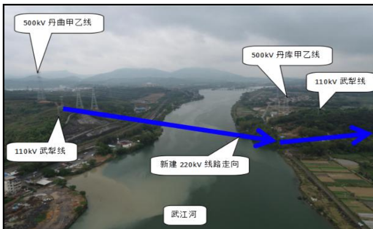
图 II-5-1 项目穿越水源保护区现状照片
