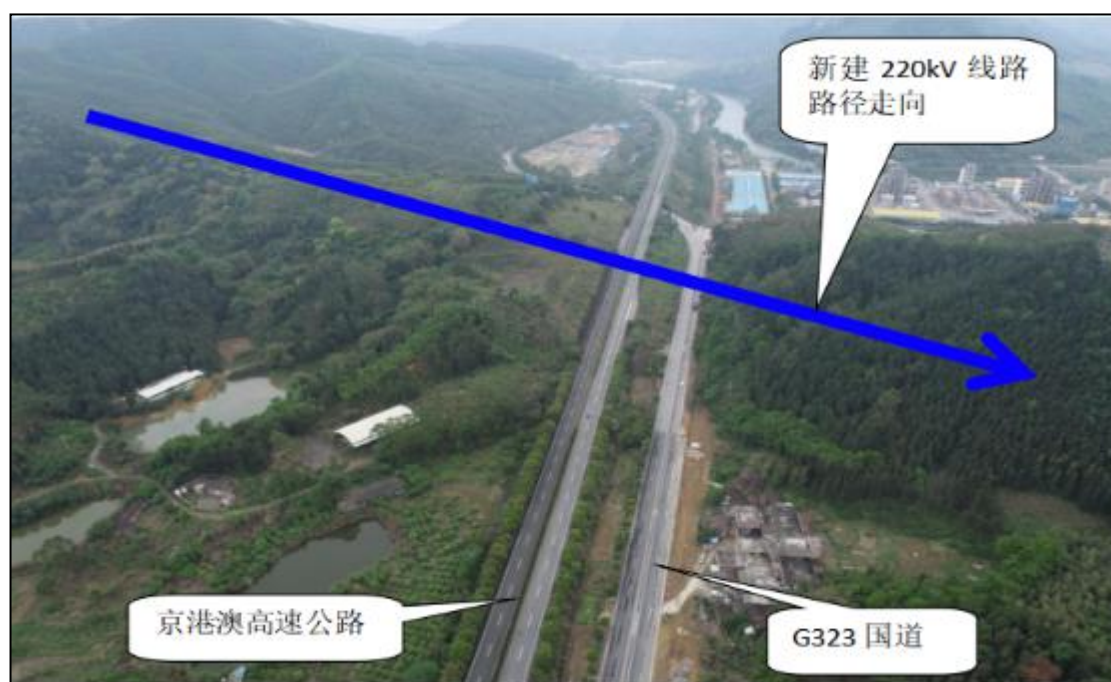
图 2-5 跨越京港澳高速公路、跨越 G323 国道
