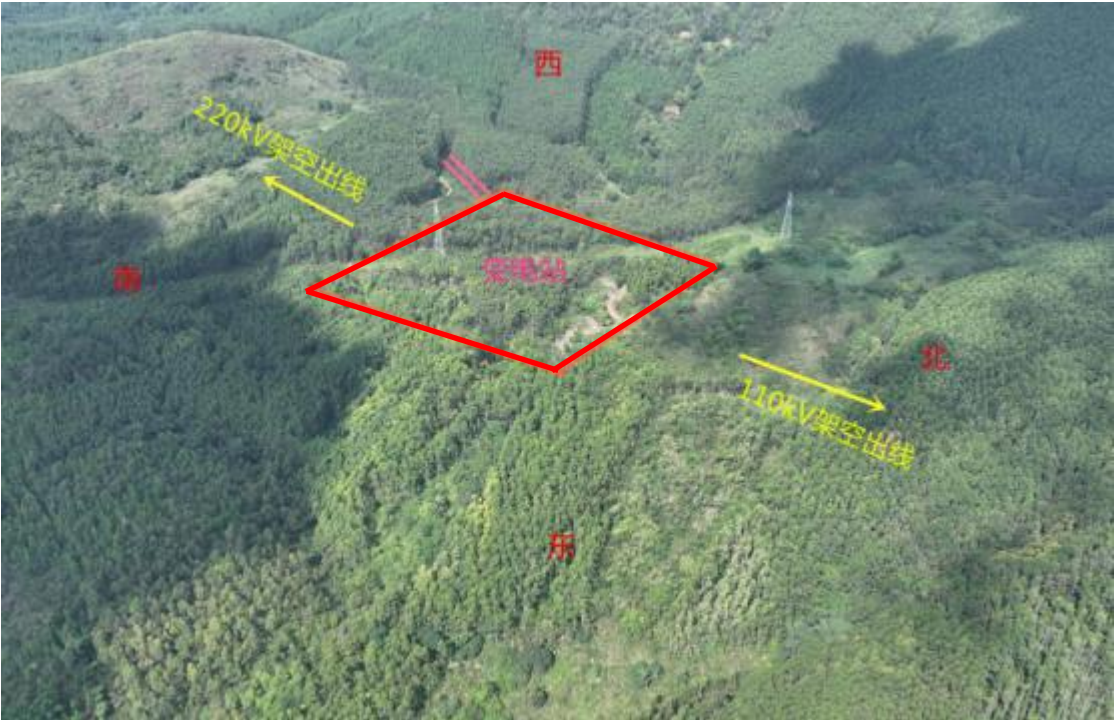
图 2-8 220kV 华韶站址现状照片
