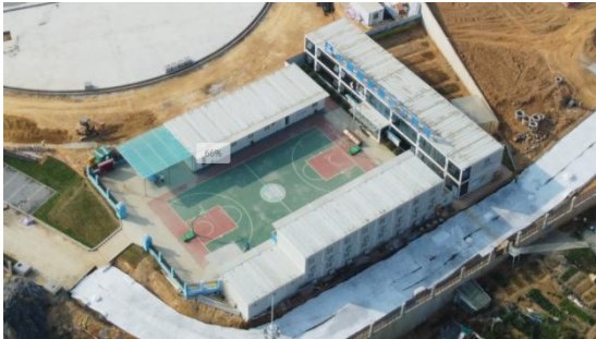
项目北侧临时施工营地
