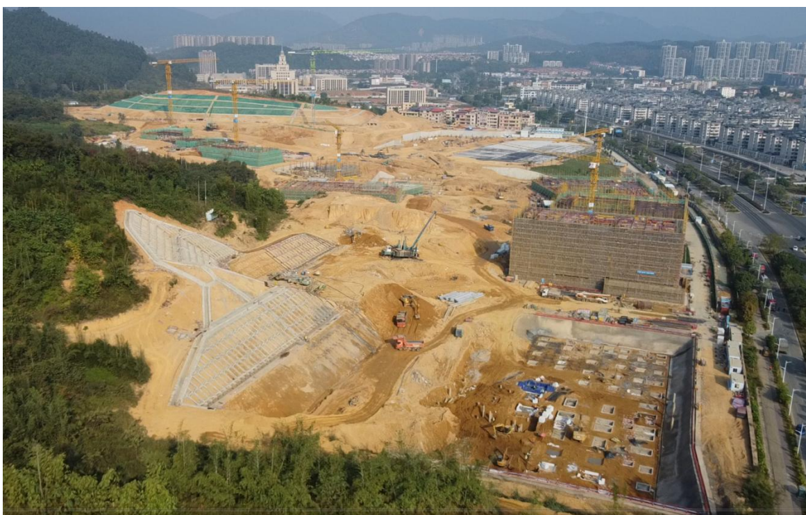
拟建一期工程现状全貌（2024 年 11 月）
