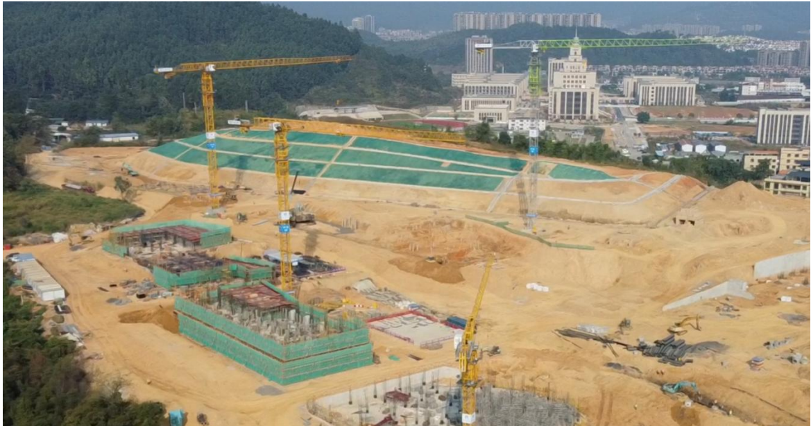
拟建工程北侧山体开挖及边坡防护现状（2024 年 11 月）
