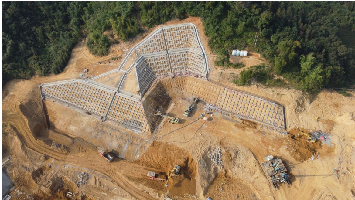
拟建工程东南侧山体开挖及边坡防护现状（2024 年 11 月）
