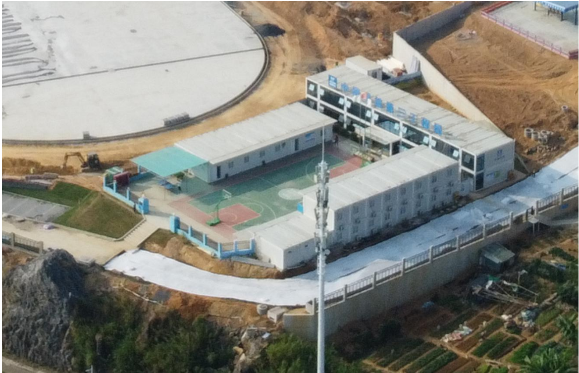
拟建工程区施工临建区现状（2024 年 11 月）
