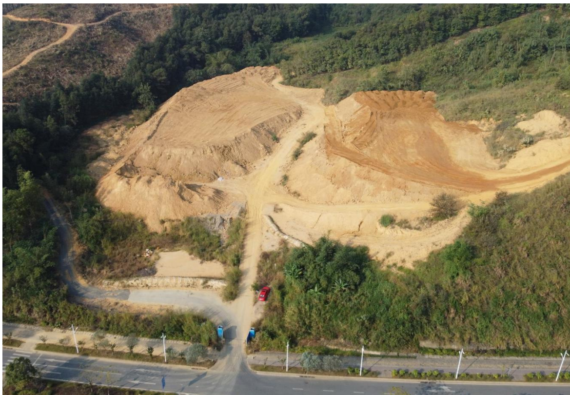
临时堆土区现状（2024 年 11 月）
