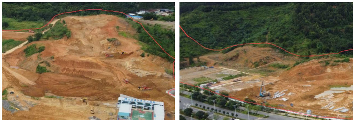
图 2.5-2 主体设计北部及一期南部山体开挖区现状
