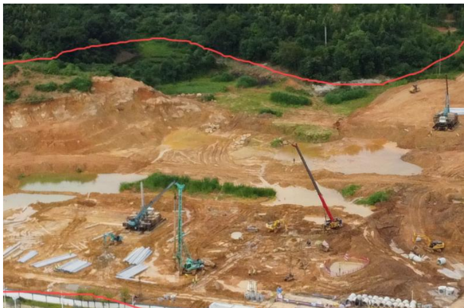
图 2.5-3 主体设计一期中部低洼区域回填现状
