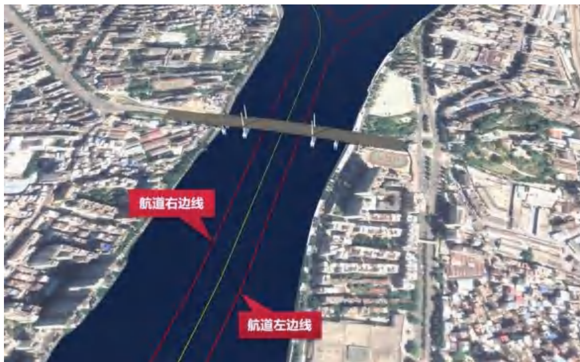
图2.4-2 北江大桥桥区航道线路图
