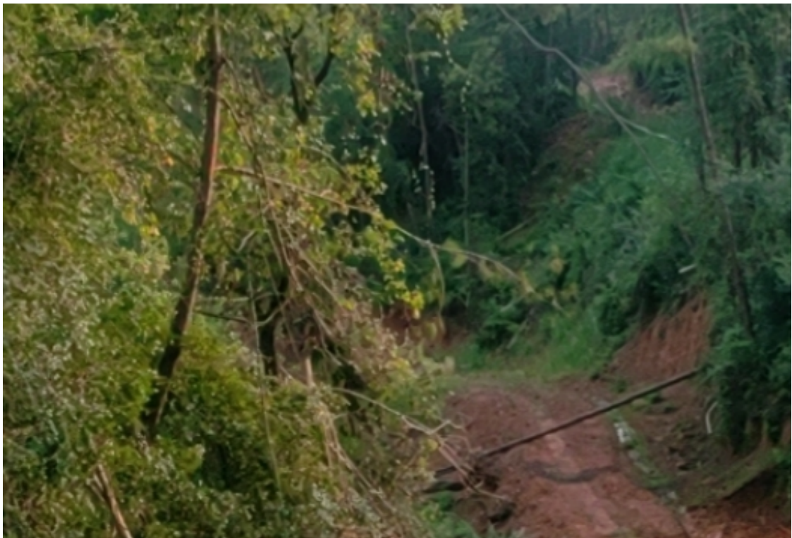
弃渣场现场照片
