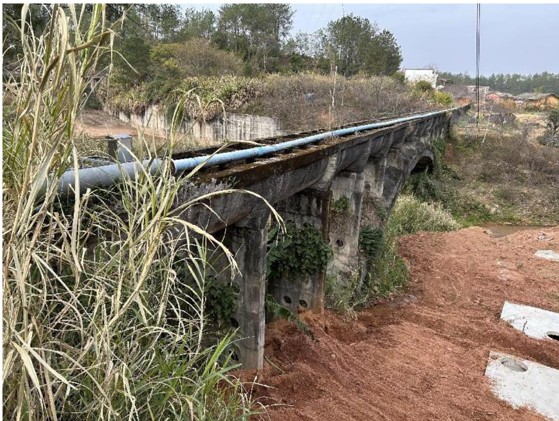
中干渠黄竹坪 1#渡槽
