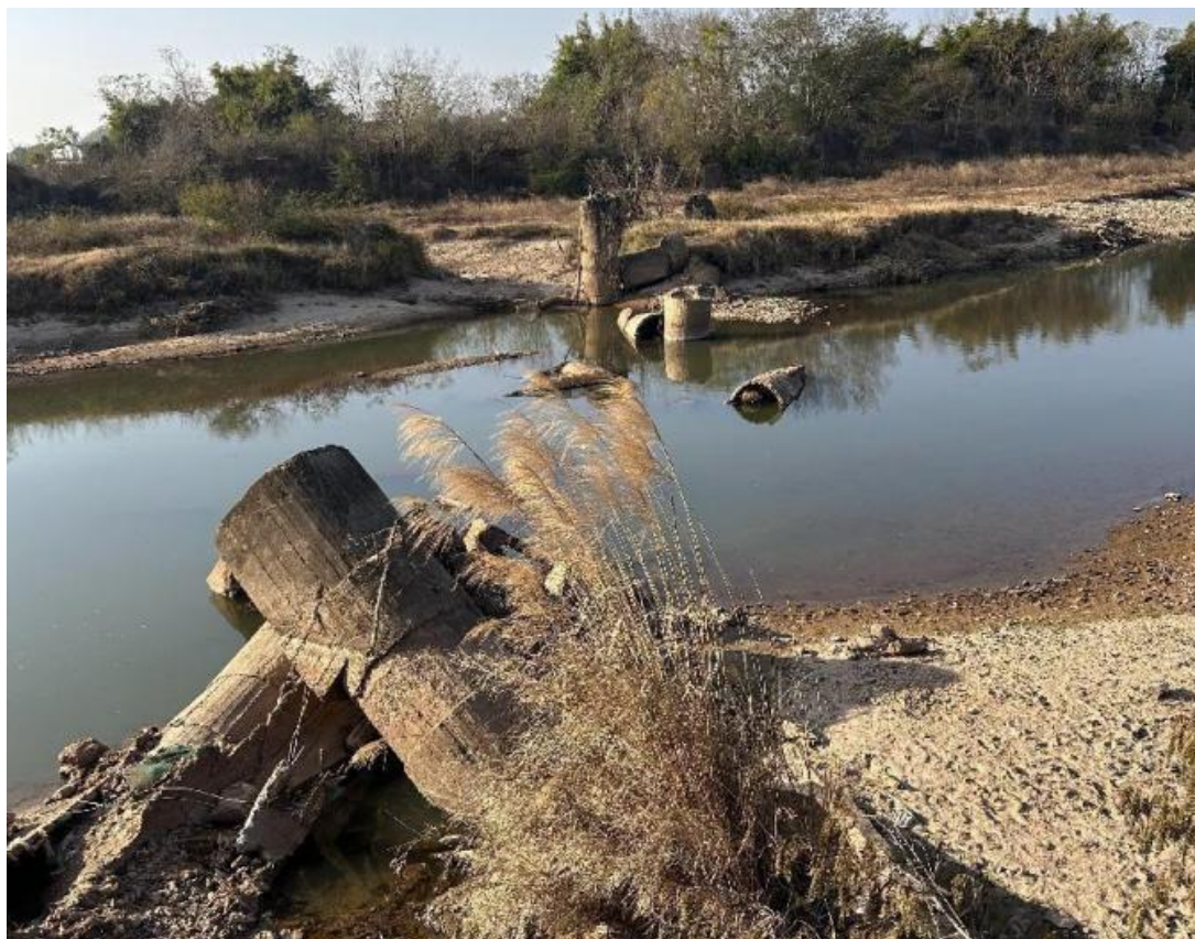
头渡大渡槽拆除后槽墩遗址
