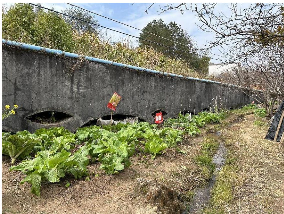
中干渠落地渡槽
