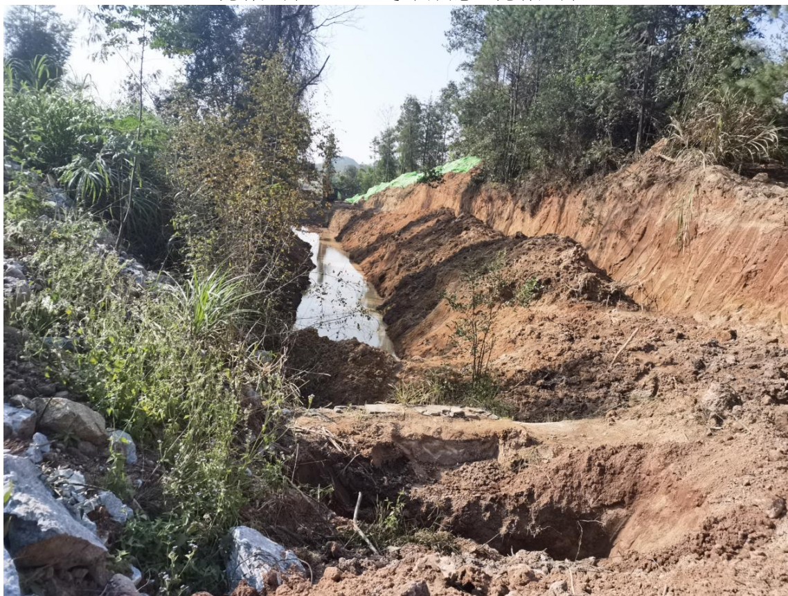
现场照片二 总干渠开挖现状照片
