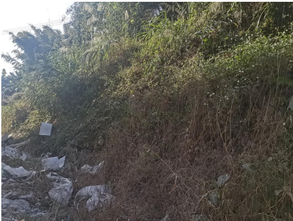
现场照片一 总干渠施工现场照片
