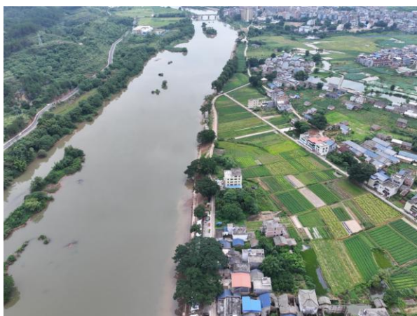
护岸段 ZK0+292~ZK0+857 现状
