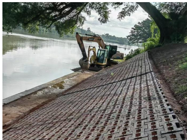
护岸段植草砖施工现状
