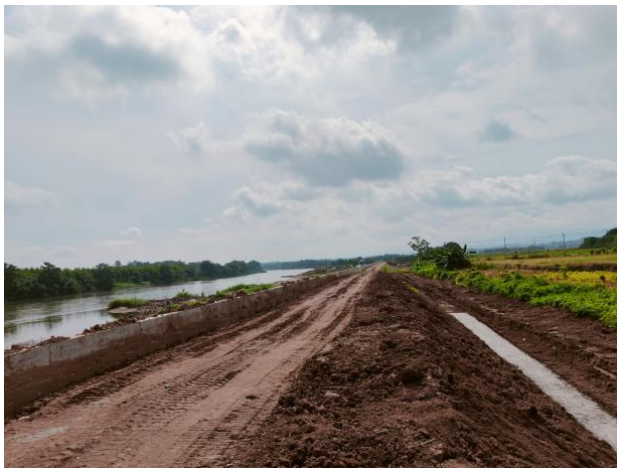
堤防段背水坡面现状
