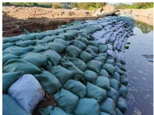
施工围堰现场施工图
