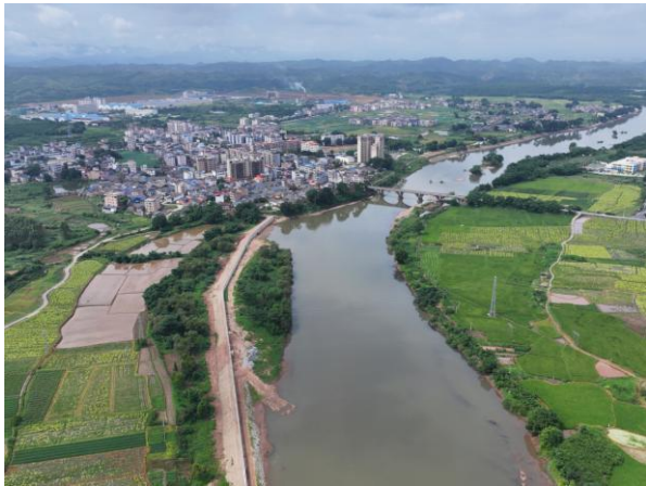
堤防段 ZK1+292~ZK2+513 现状
