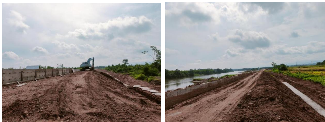
堤防段现场施工情况（2024 年 6 月拍摄）
