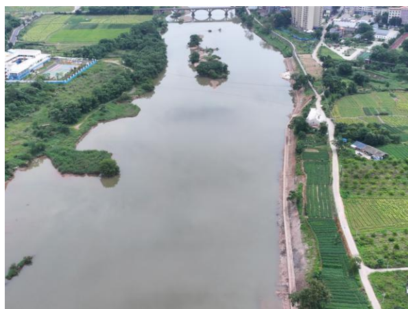
护岸段 ZK0+857~ZK1+319 现状
