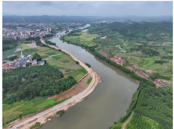
堤防段 ZK2+513~ZK2+983 现状
