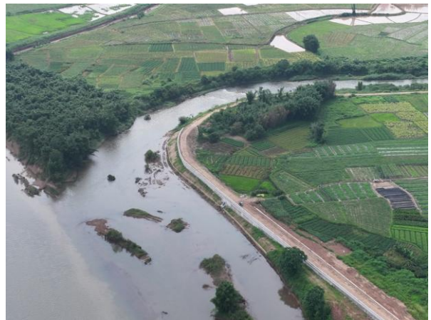
堤防段 ZK3+603~ZK3+913 现状
