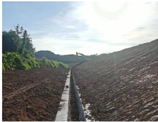
排水沟施工现状
