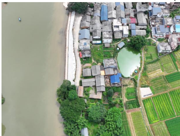
护岸段 ZK0+000~ZK0+091 现状
