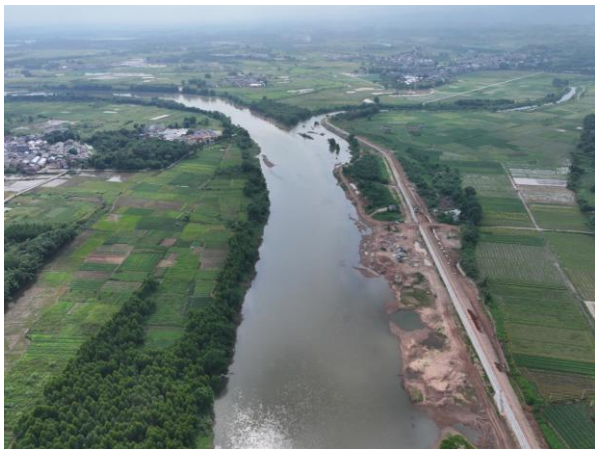
堤防段 ZK2+983~ZK3+603 现状
