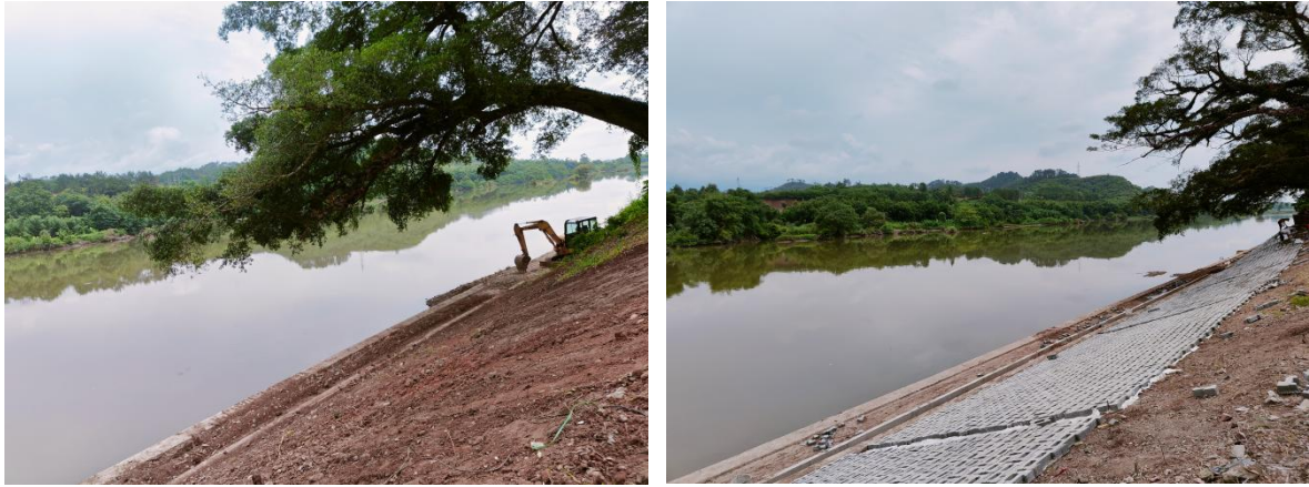
护岸段现场施工情况（2024 年 6 月拍摄）
