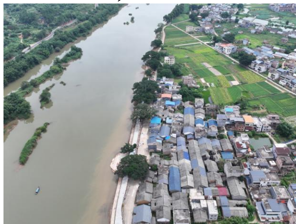
护岸段 ZK0+091~ZK0+292 现状
