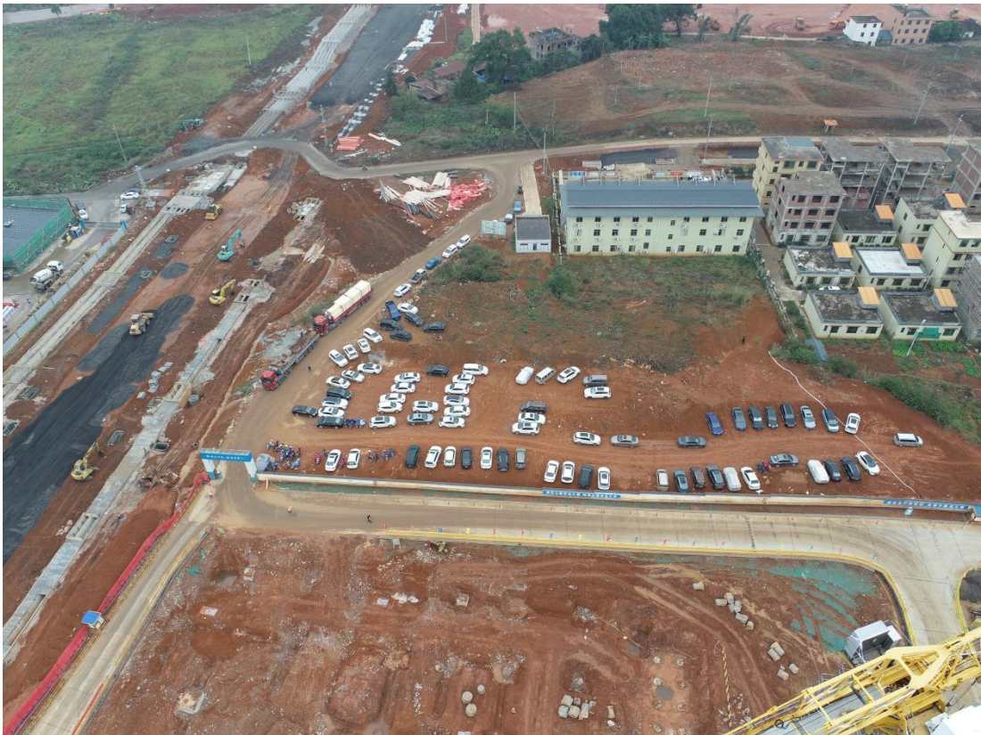
110 千伏凉教 2 变电站址现状
