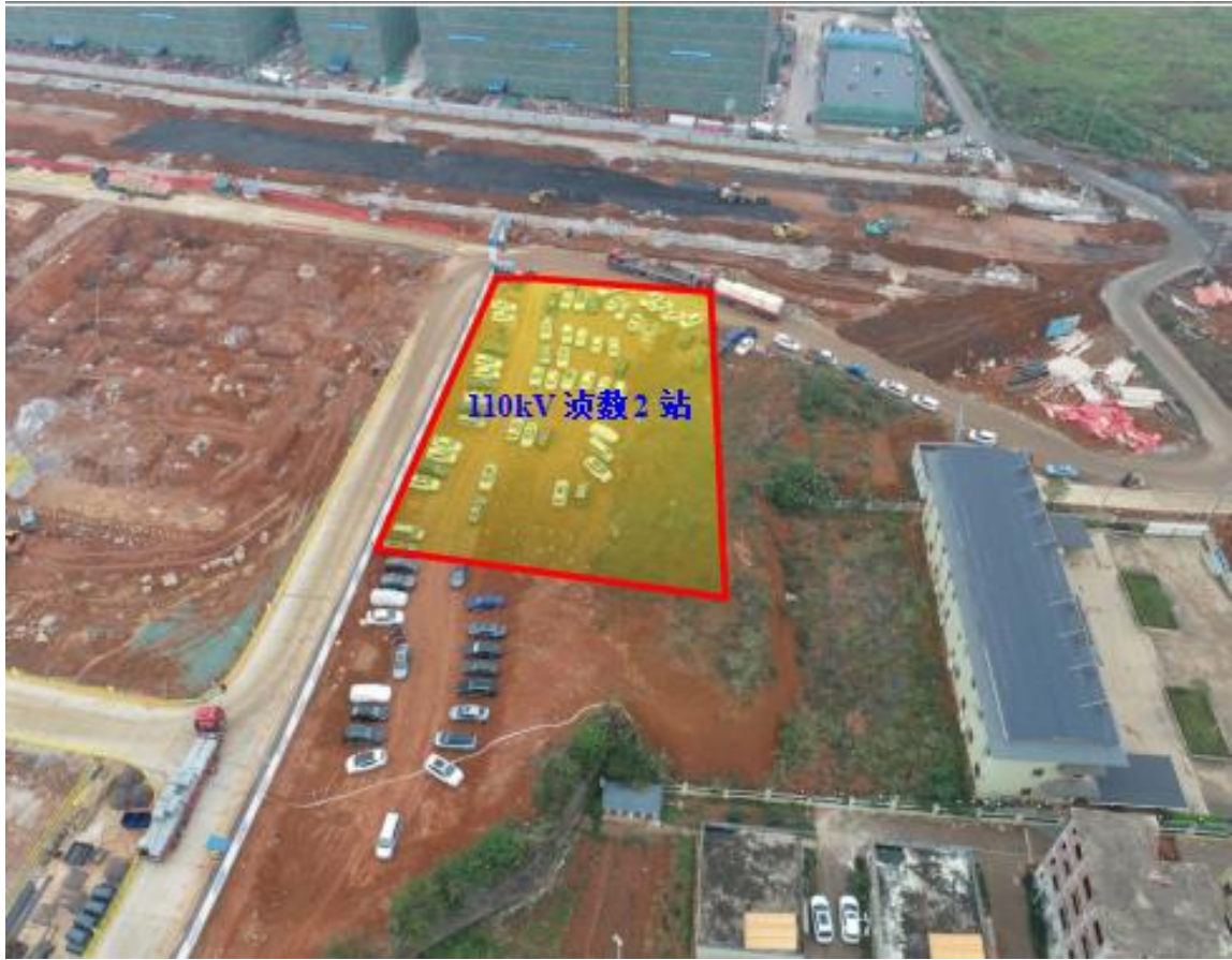
110 千伏凉教 2 变电站址航拍图
