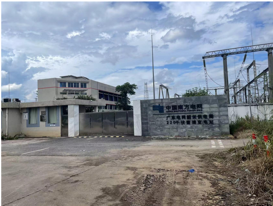
照片 7 220kV 董塘变电站
