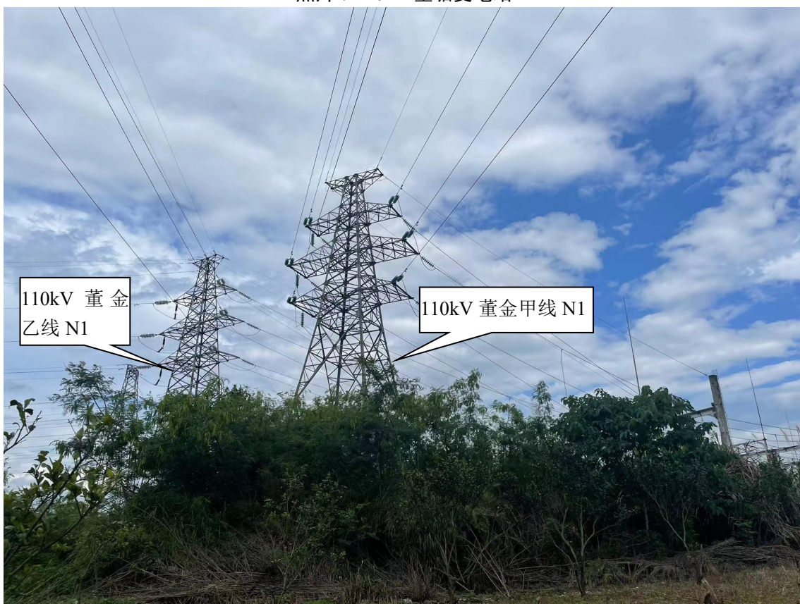
照片 8 110kV 董金甲线和乙线 N1 杆塔
