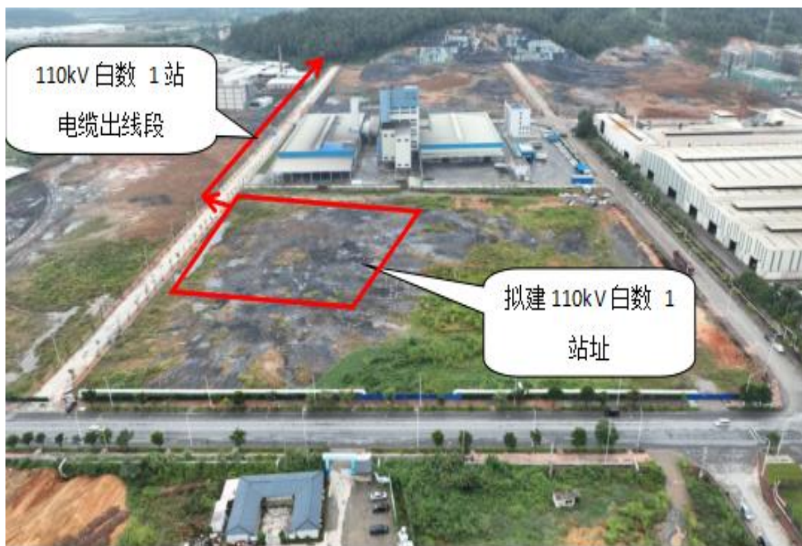
110kV 白数 1 拟建站址及出线段现状
