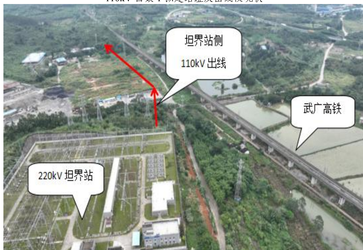
220kV 坦界站 110kV 侧出线
