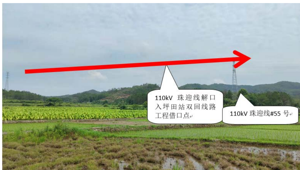
110kV 珠迎线解口入坪田站双回线路工程起点
