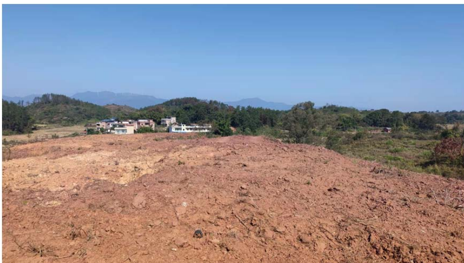
110kV 坪田站现状
