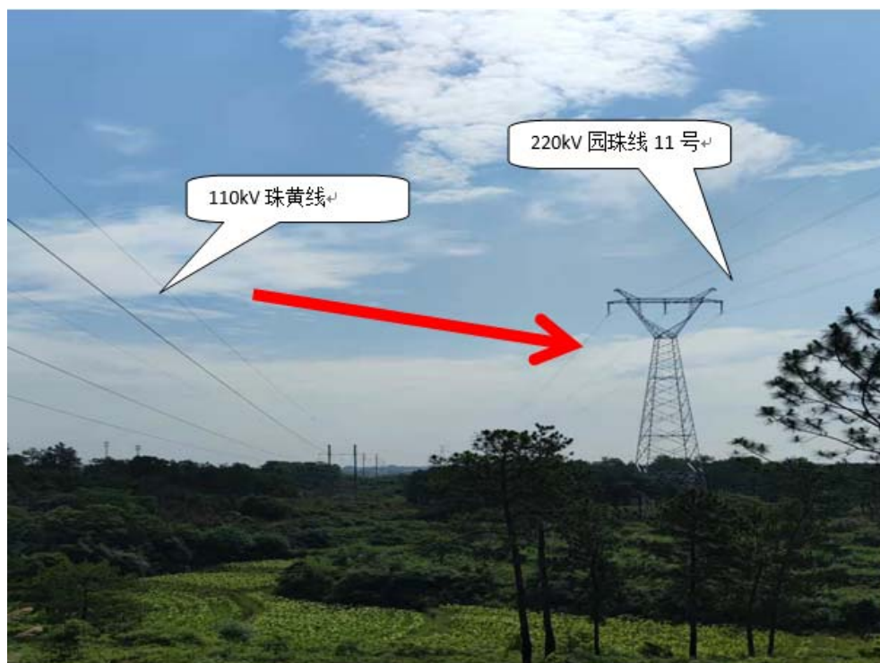
110kV 线路跨越 110kV 珠黄线及 220kV 园珠线
