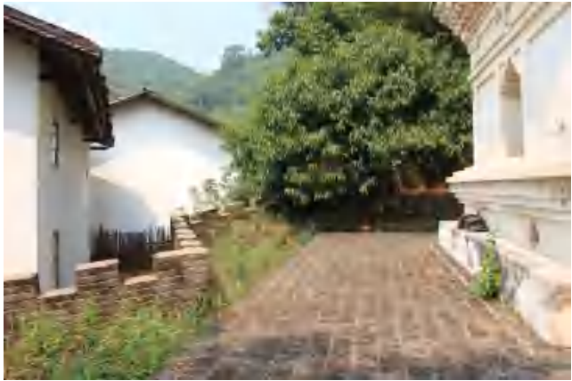
图 9 2015 年渐溪寺塔旁边民居（砖木结构）
