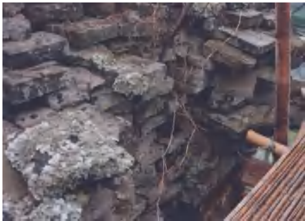
图 17-7 修缮前渐溪寺塔照片
