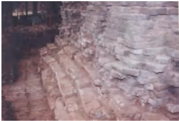
图 17-5 修缮前渐溪寺塔照片
