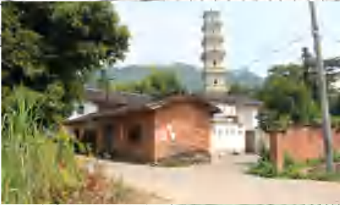
淞溪寺塔及塔旁建筑。
