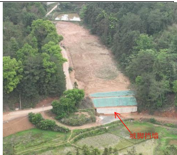
TJ1-1#弃渣场航拍照片
