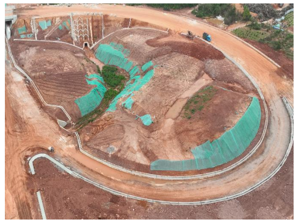
互通内布置的排水沟、骨架护坡措施（2023.4）
