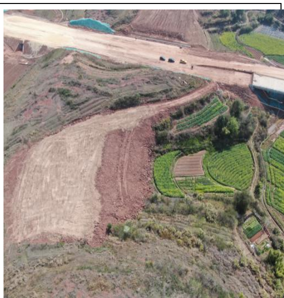
TJ2-2#弃渣场航拍照片
