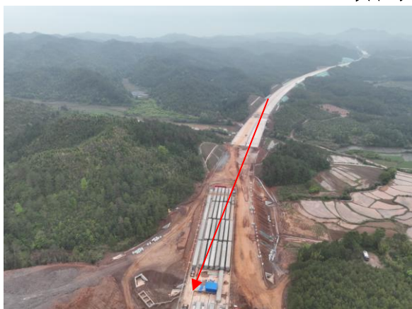
线路起点至界址互通现状 (2023.4)
