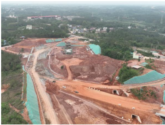
长市互通施工场地现状（2023.4）
