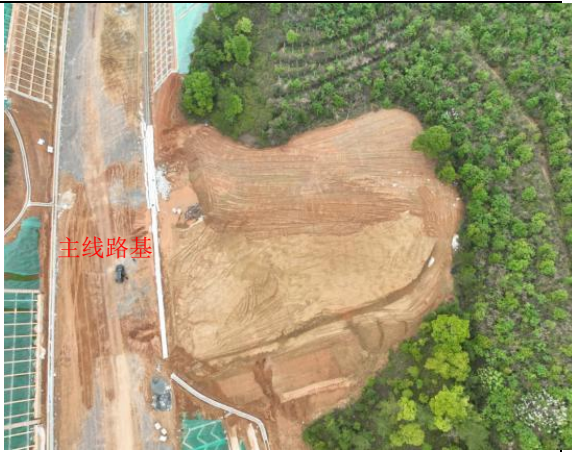
TJ1-4#弃渣场航拍照片
