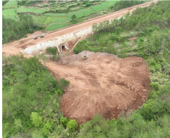
TJ2-3#弃渣场航拍照片
