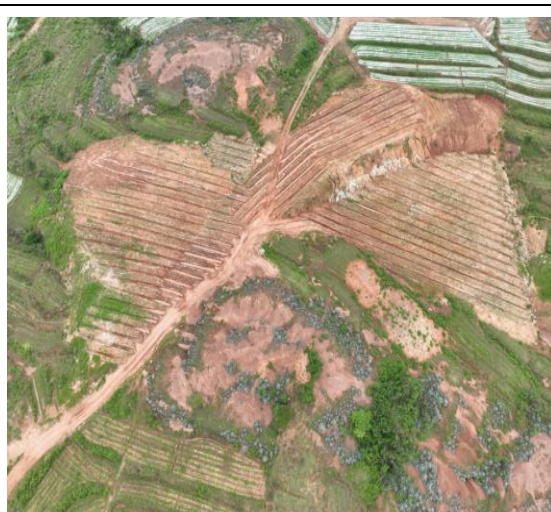
TJ3-1#弃渣场航拍照片
