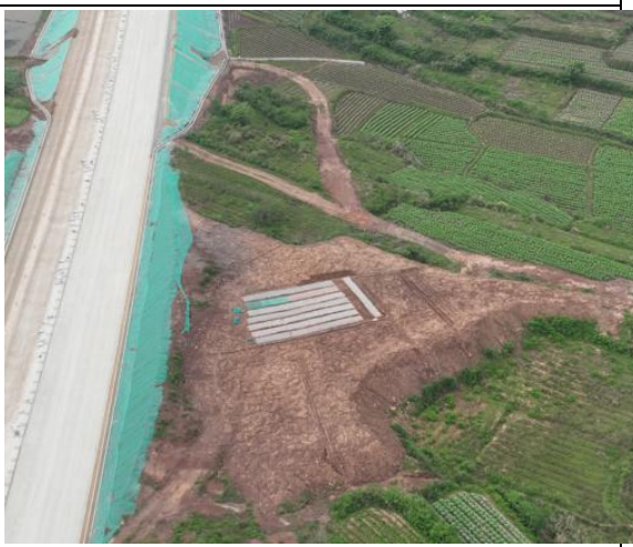
TJ2-1#弃渣场航拍照片
