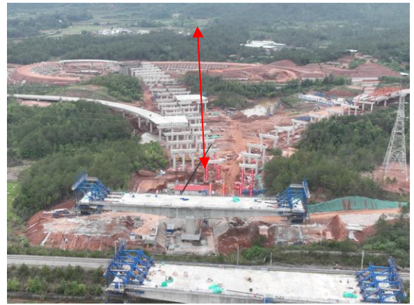
珠玑北枢纽互通施工场地现状（2023.4）
