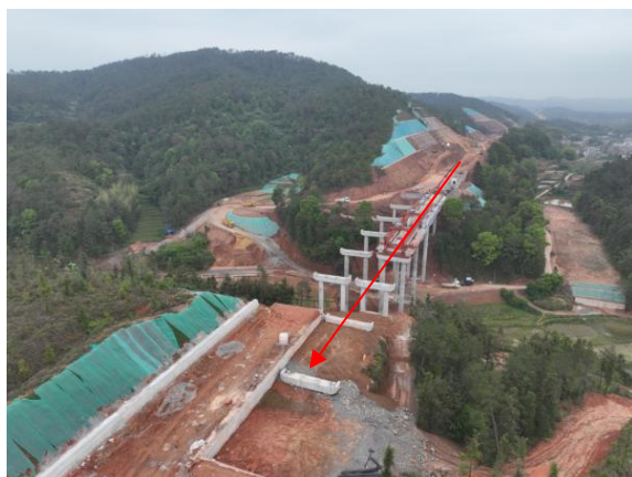
十八斗大桥现状 (2023.4)
