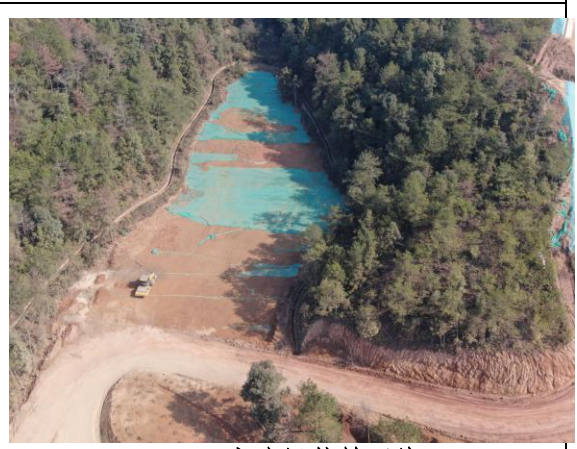
TJ1-2#弃渣场航拍照片
