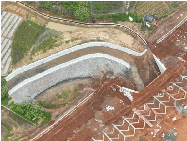
互通内布置的排水沟、骨架护坡措施（2023.4）
