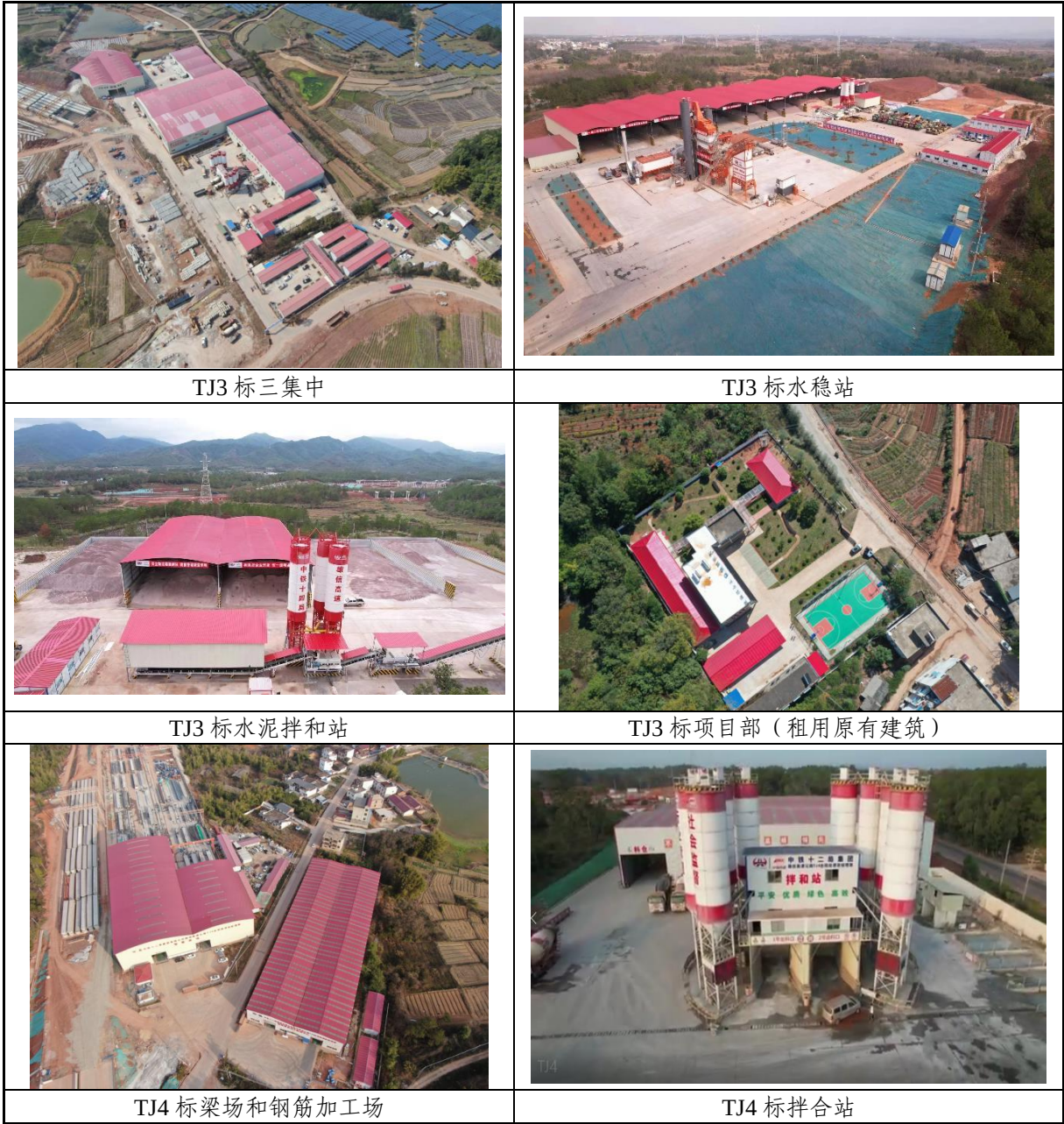
图 2.2-1 施工生产生活区现场照片（2023.4）
