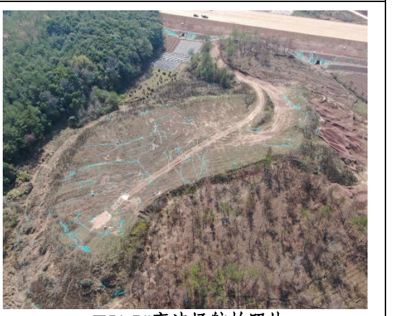
TJ1-5#弃渣场航拍照片
