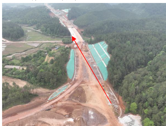
界址互通至桩号 K3+000 段现状 (2023.4)
