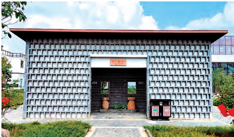
2021年9月26日,翁源县江尾镇新改建的松岗村公厕
