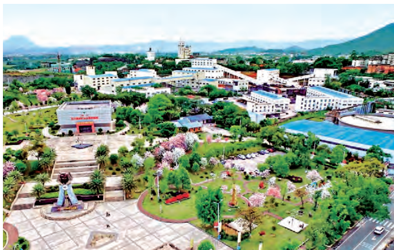
凡口矿山公园和采掘废石全资源化利用技术改造项目现场 (凡口铅锌矿 供)
