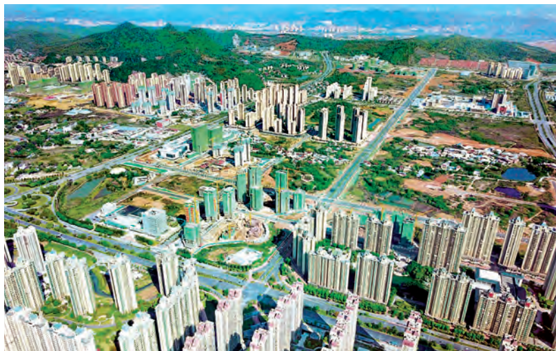
建设中的芙蓉新区
