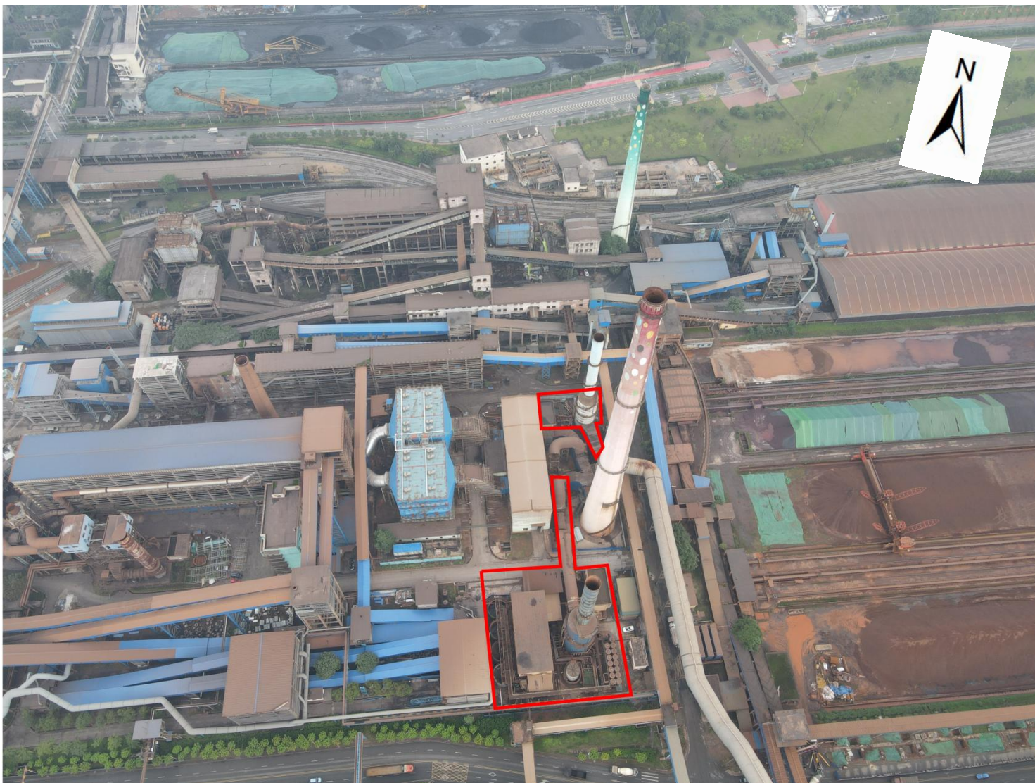
图 2.2-6 六号烧结机湿法脱硫拆除区域现场航拍图
