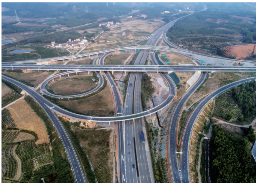
▲2017年12月28日建成通车的武深高速仁化段立交枢纽（谢锦树 摄）
