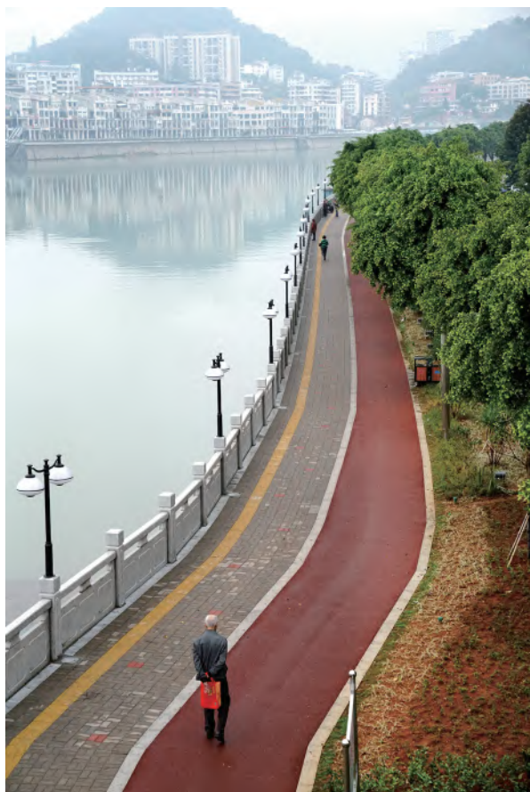
2017年，韶关市区旧河堤加固工程 提升城市功能（韶关日报社 供）
