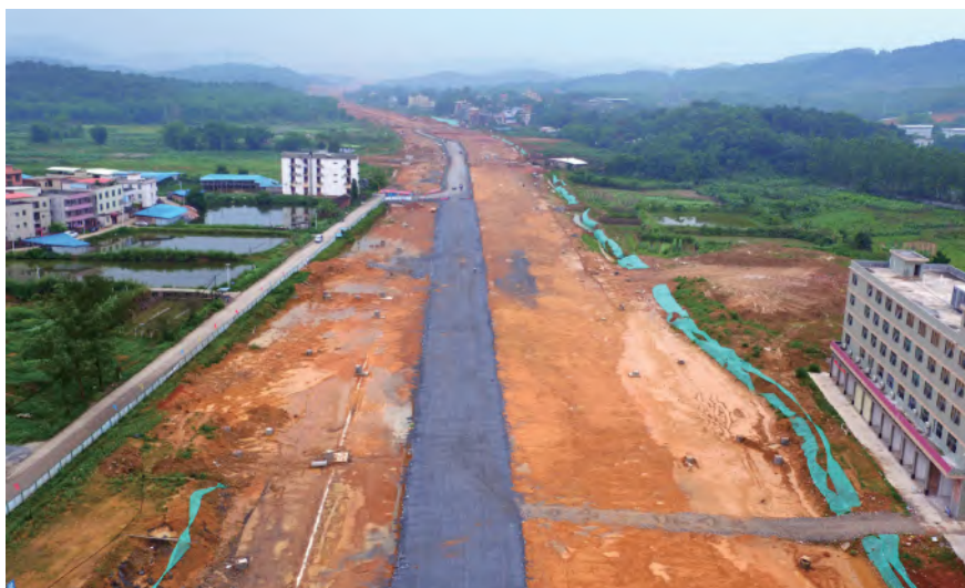
2017年，跨越韶关市浈江区和韶关市曲江区的莲花大道（二期）工程建筑工地（张伟 杨纯 刘嘉健 摄）
