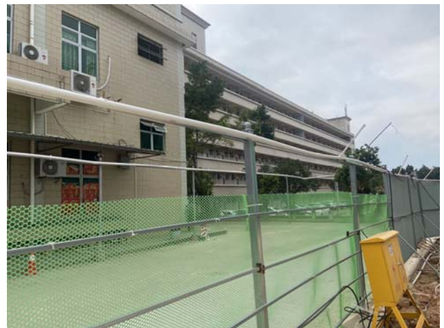
项目东南侧 工业区宿舍楼
