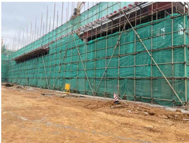
项目所在厂房现状
