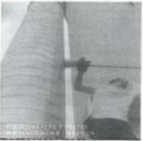
3#排气筒废气处理后
