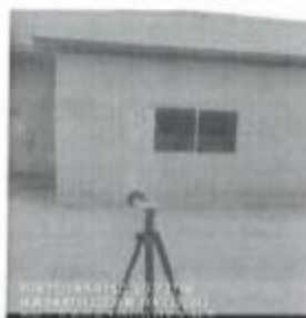
6#厂界西北面 1 米外
