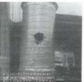
5#排气筒废气处理前
