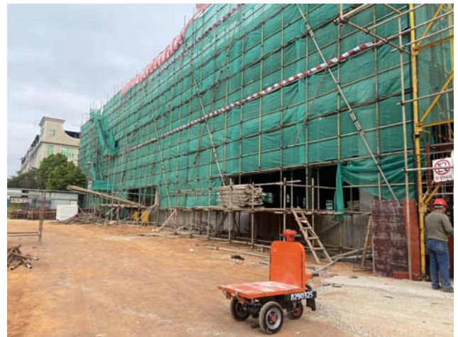
项目所在厂房现状
