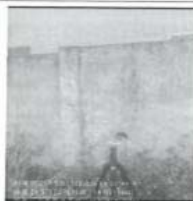
4#厂界东南面 1 米外
