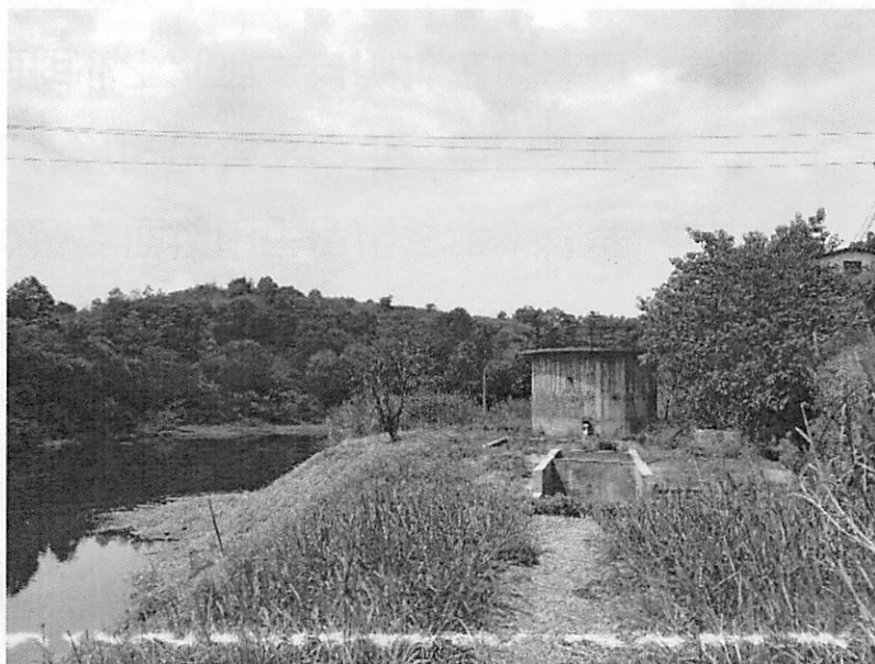
填埋场现场照片
