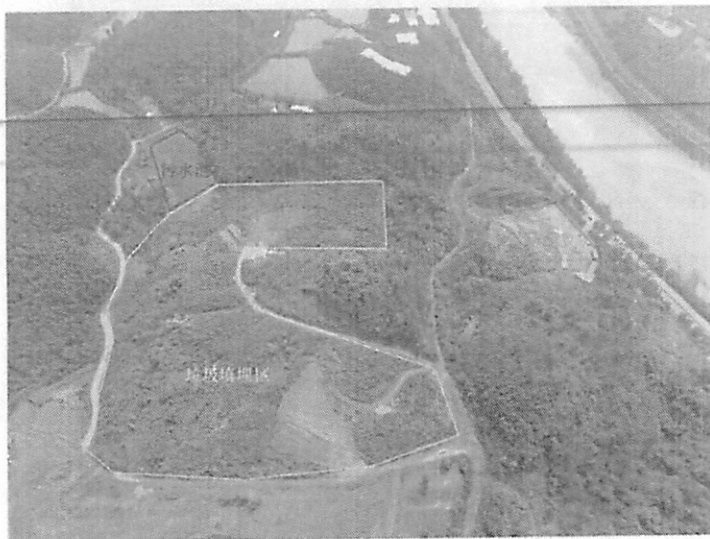
图 3-1 项目现状航拍图
