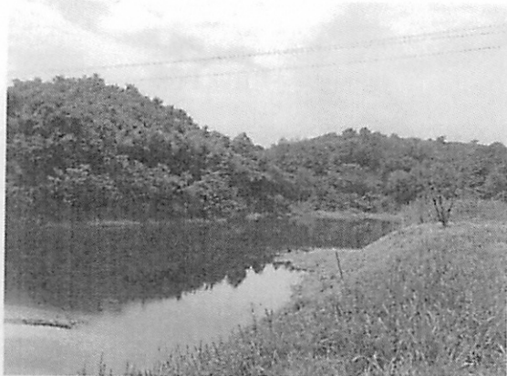
图 3-3 渗滤液污水池现场照片
