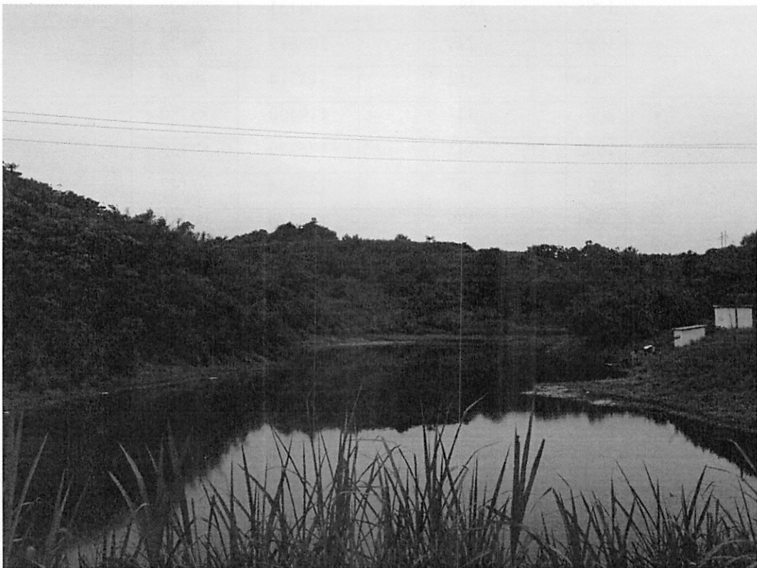
图3-3 中厂山垃圾填埋场渗沥液污水池
