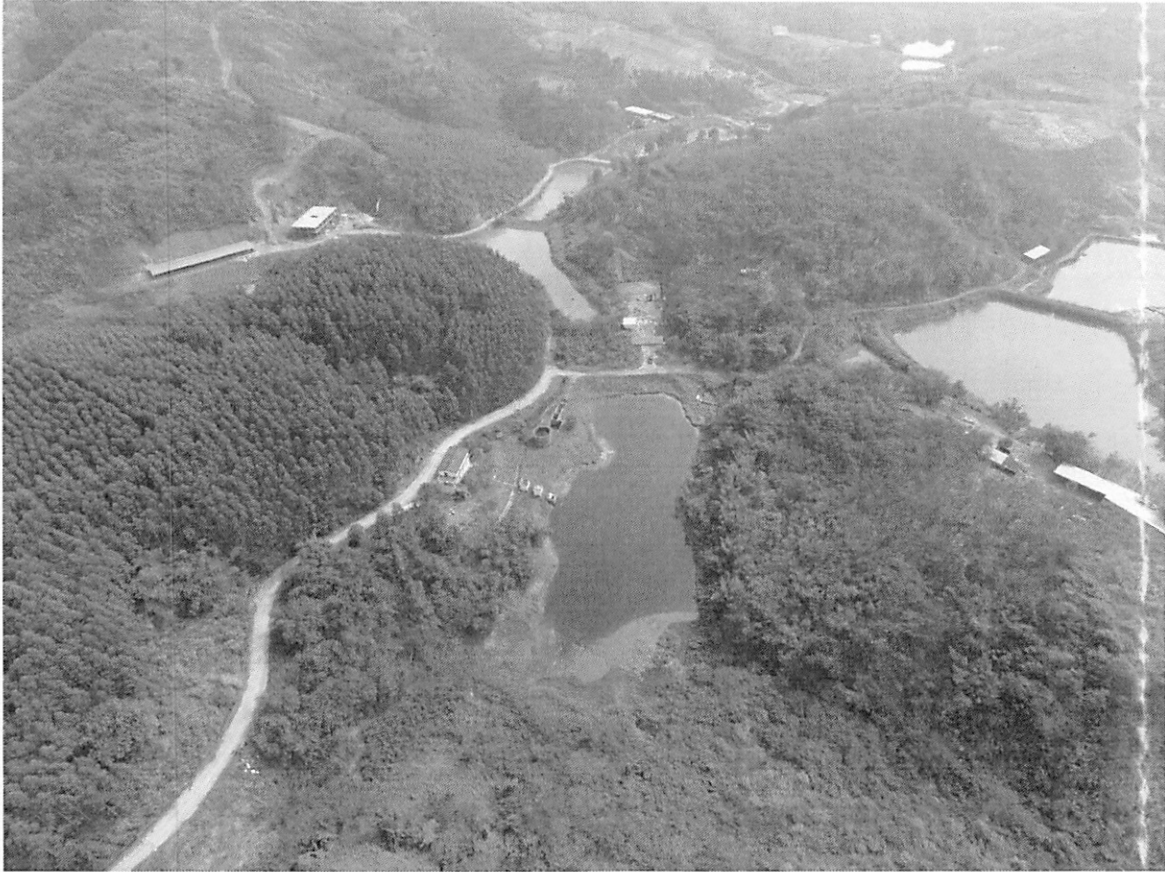
图3-4 中厂山垃圾填埋场污水池现状航拍图
