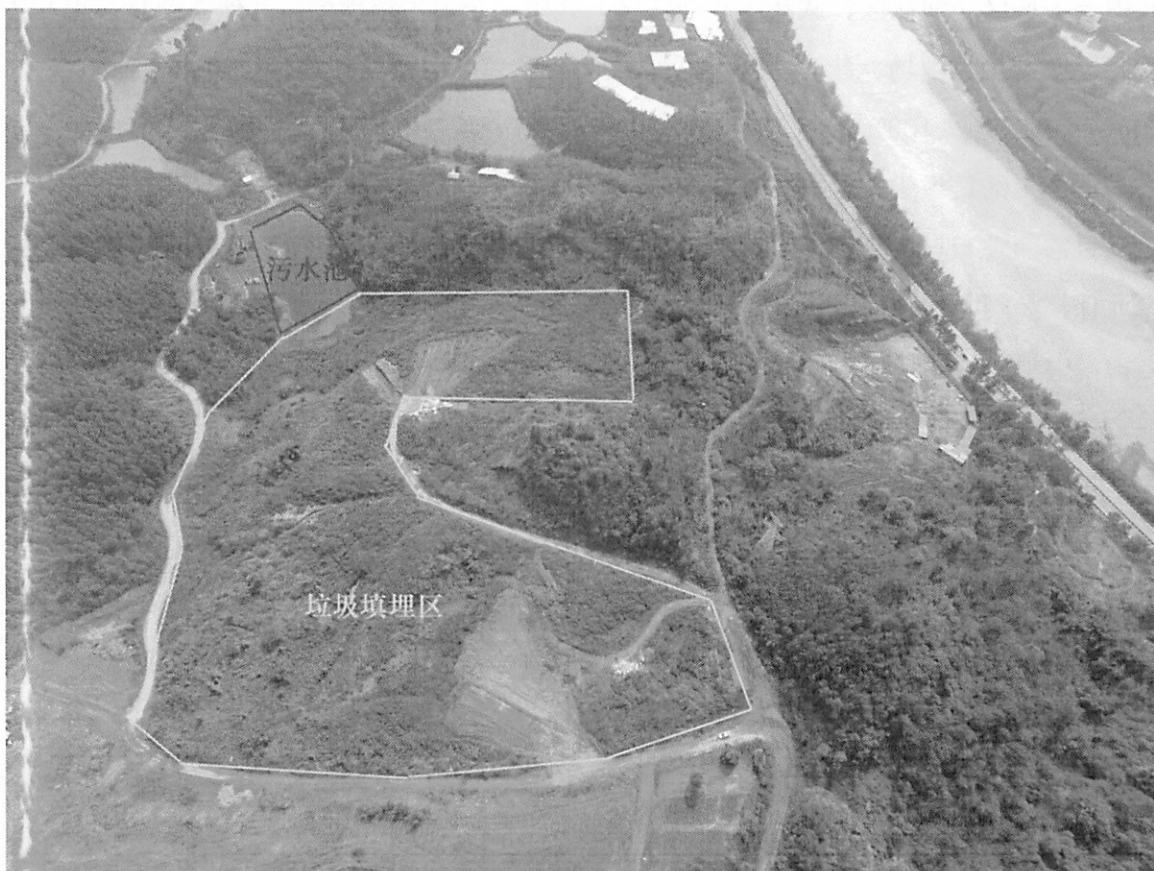
图 3-1 中厂山垃圾填埋场现状航拍图
