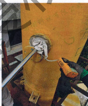
PCD1 车间工艺废气排放口
