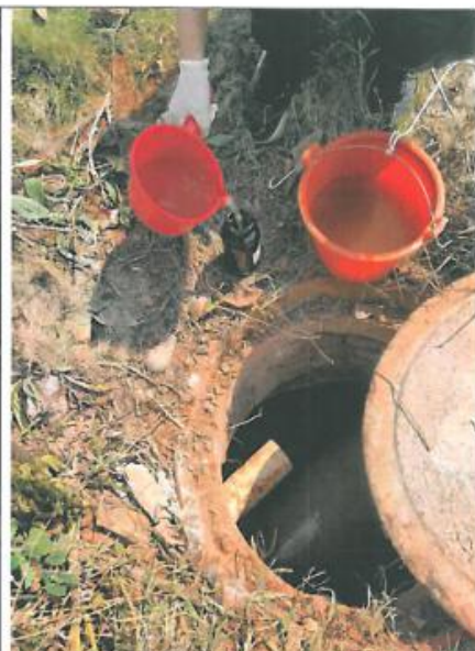
图 9.2 生活污水排放口 ★W2
