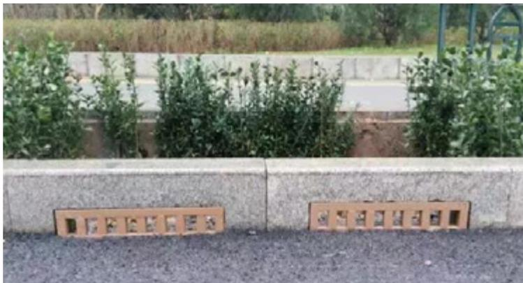
在树池带上游的路缘石上开孔并且局部加大慢车道的横坡以加强收水效果，使雨水通过路缘石进入树池带。
